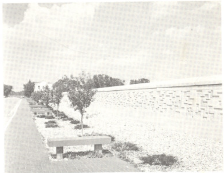
Pembina Flood Wall
