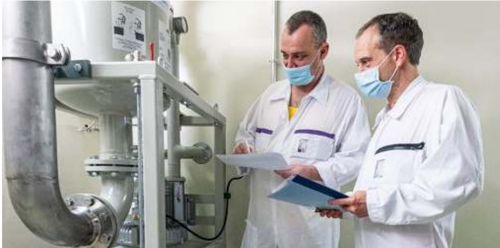
Im Containment: Inbetriebsetzung eines Öldunstgeblä- ses für die Unter- druckregulierung im Schmierölsystem einer Hauptkühlmit- telpumpe. Bild: Kernkraftwerk Gösgen
