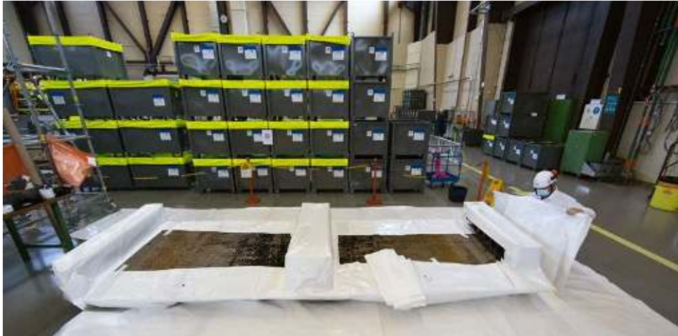
Material wird foliert für den anschliessenden Transport. Bild: Kernkraftwerk Mühleberg
