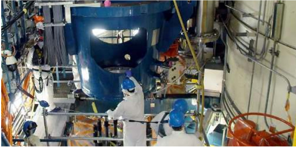
Transport der Pumpenlaterne für den Ersatz des Reaktorumwälzsystems. Foto: KKL
