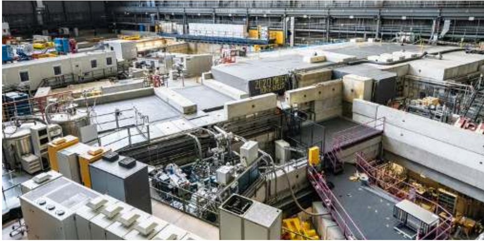
Experimentierhalle. Foto: Zwilag
