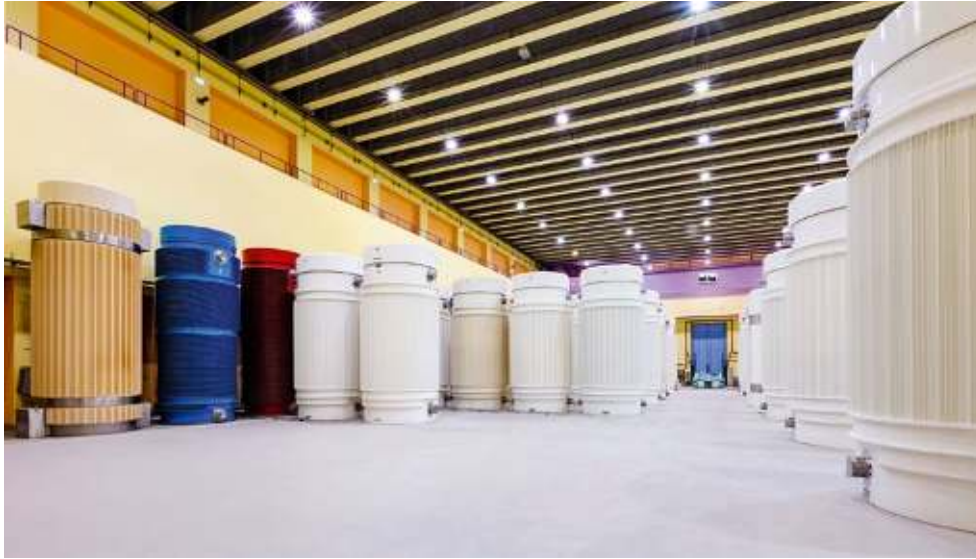
Lagerhalle für hochaktive Abfälle. Foto: Zwiilag
