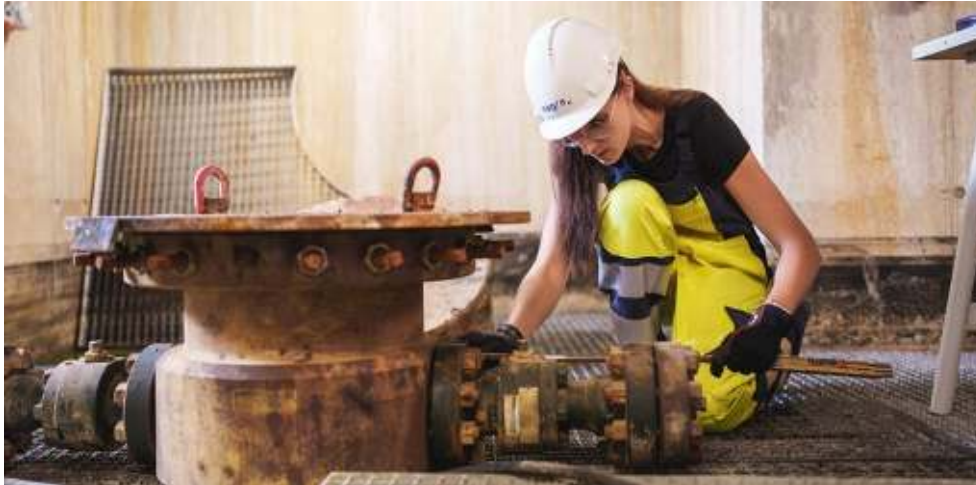
Arbeiten auf dem Bohrplatz Bachs. Foto: Nagra
