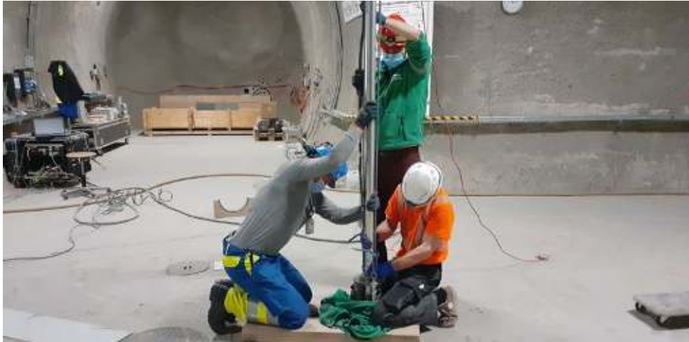
Einführung einer RFA-Sonde, Experiment im Felslabor Mont Terri. Foto: swisstopo
