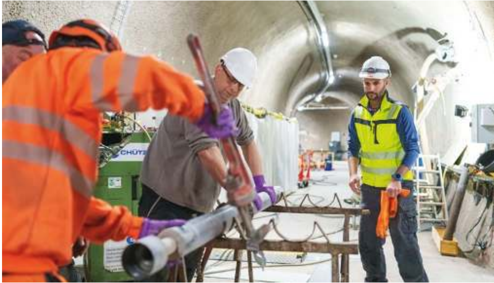
Arbeiten im Felslabor Mont Terri. Foto: Nagra
