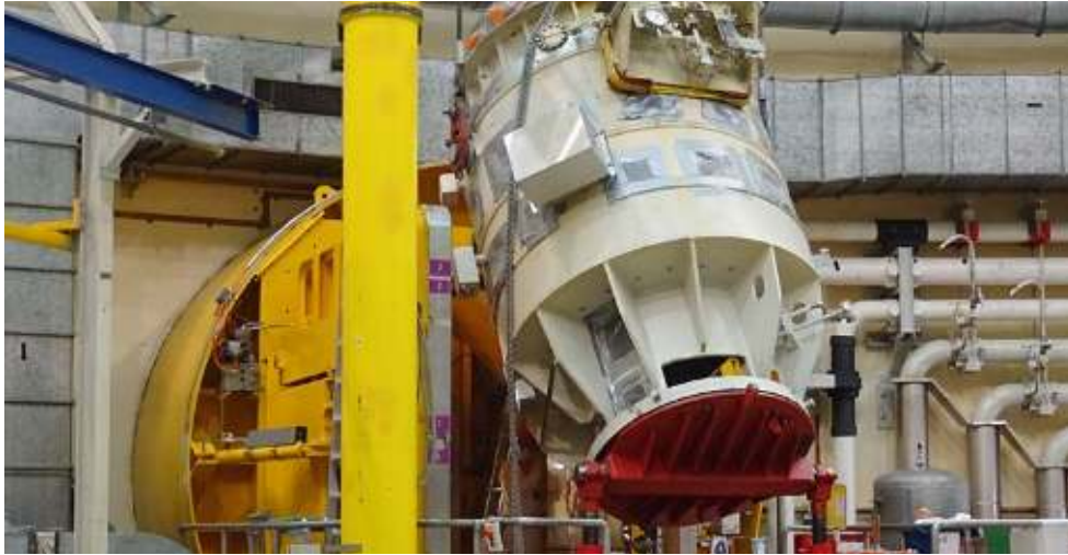
Austausch des Motors der Reaktor- hauptpumpe. Foto: KKB
