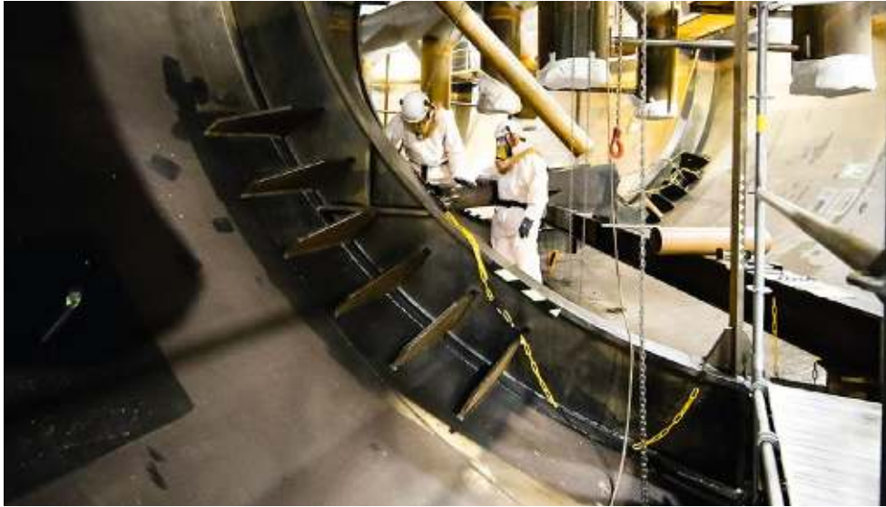
Demontagerbeiten im Torus. Foto: KKM
