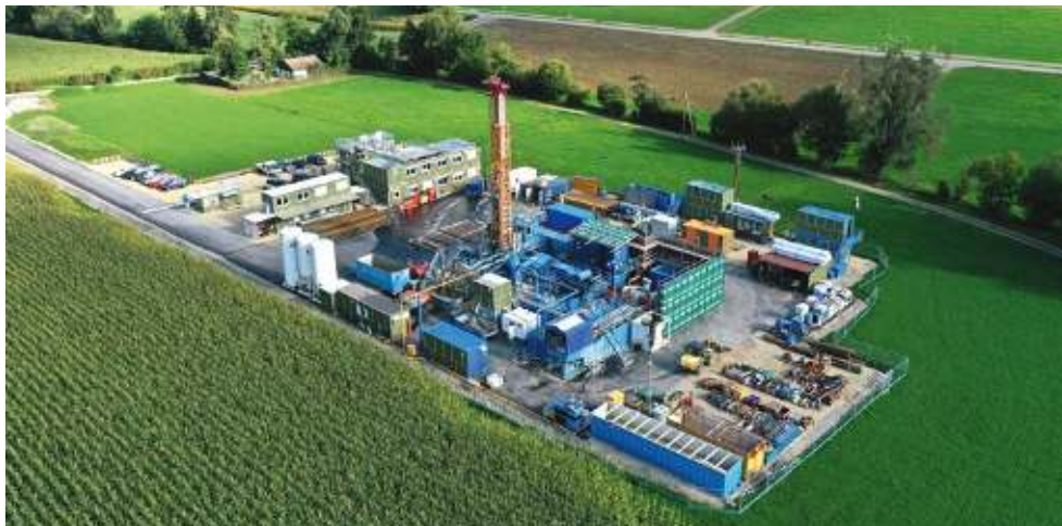
Bohrplatz Bachs. Foto: Nagra
