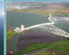
Barrera contra marejada ciclónica Maeslantkering, Netherlands
