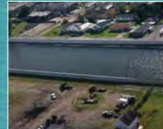
Diques de protección reconstruidos, New Orleans, Louisiana
