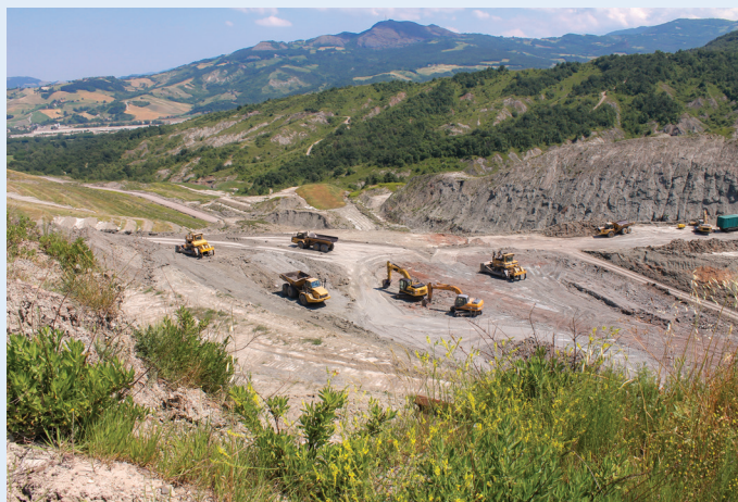
Figure 6 : Des véhicules de construction changent la terre.
