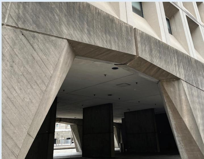
Figure 17 : un mur de bâtiment noirci au fil du temps par les particules fines présentes dans l'air.
