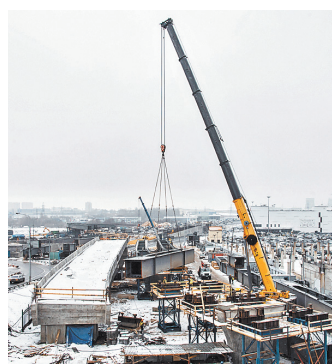
На пересечении МКАД с улицей Верхние Поля продолжается реконструкция транспортной развязки.
