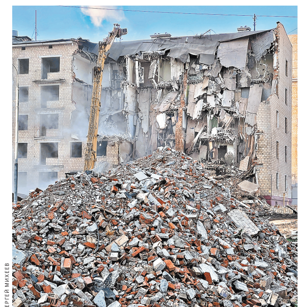
Технология «умного» сноса используется при демонтаже всех расселенных по программе реновации зданий.
