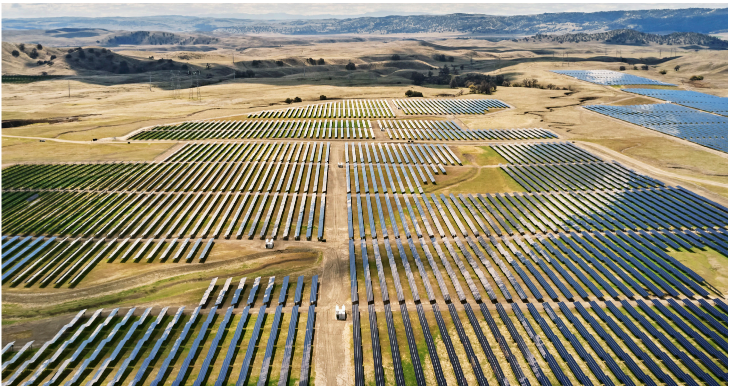
Apple 帮助打造了新的公用事业规模的储能项目,为 130 兆瓦 California Flats 太阳能电场提供支持。该电场为我们位于加利福尼亚州的场所设施提供可再生能源。
