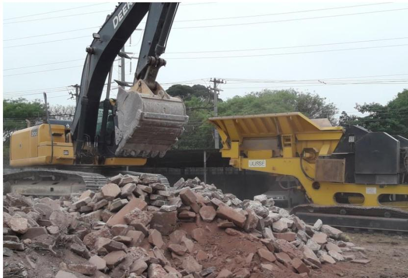
**Imagem 04:** processo de britagem de blocos de concreto
