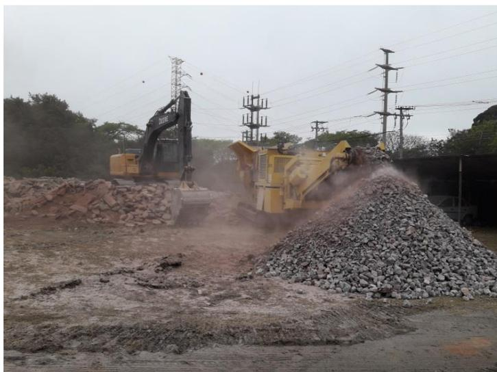
**Imagem 02:** processo de britagem de blocos de concreto, em terreno da USP na Av. Escola Politécnica
