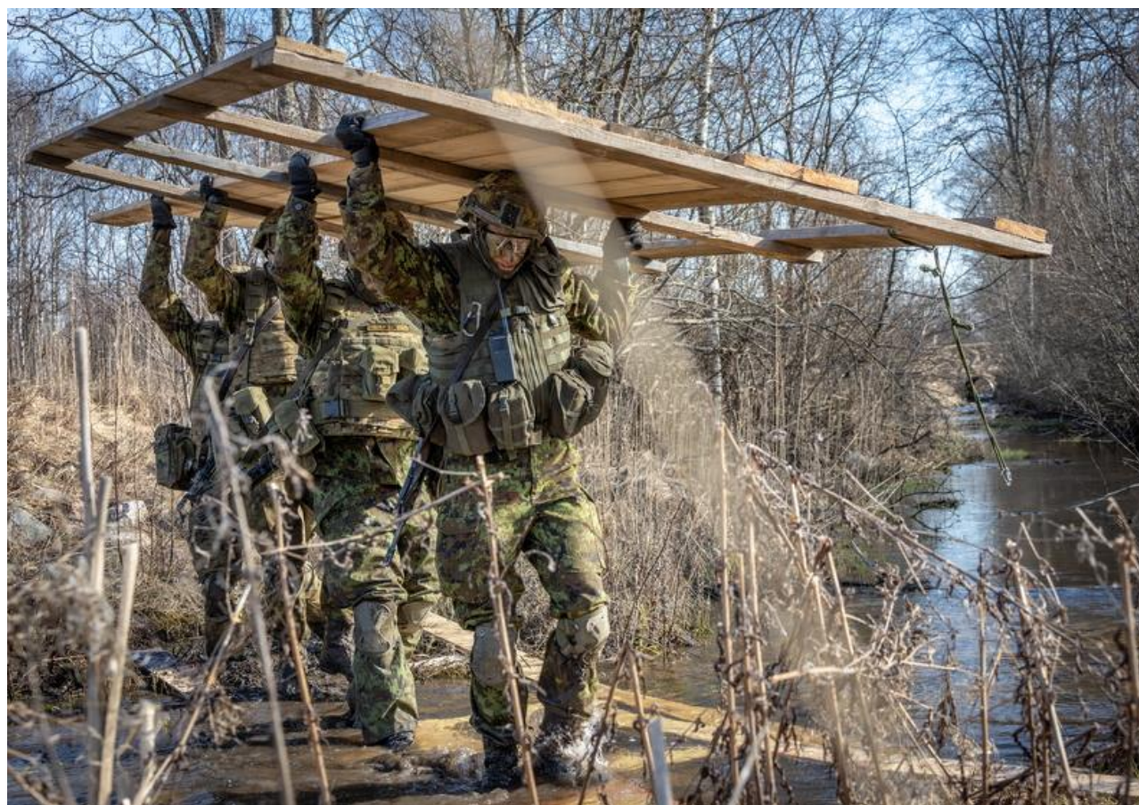
Foto 5. 1. jalaväebrigaadi pioneeripataljoni ajateenijate jooksusild üle Valgejõe (26.03.2020). Foto: n-srs Jaan Vanaaseme
