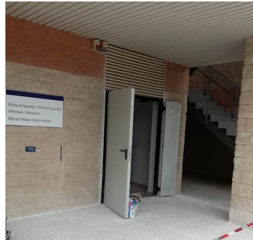
Rampa de acceso según normativa
