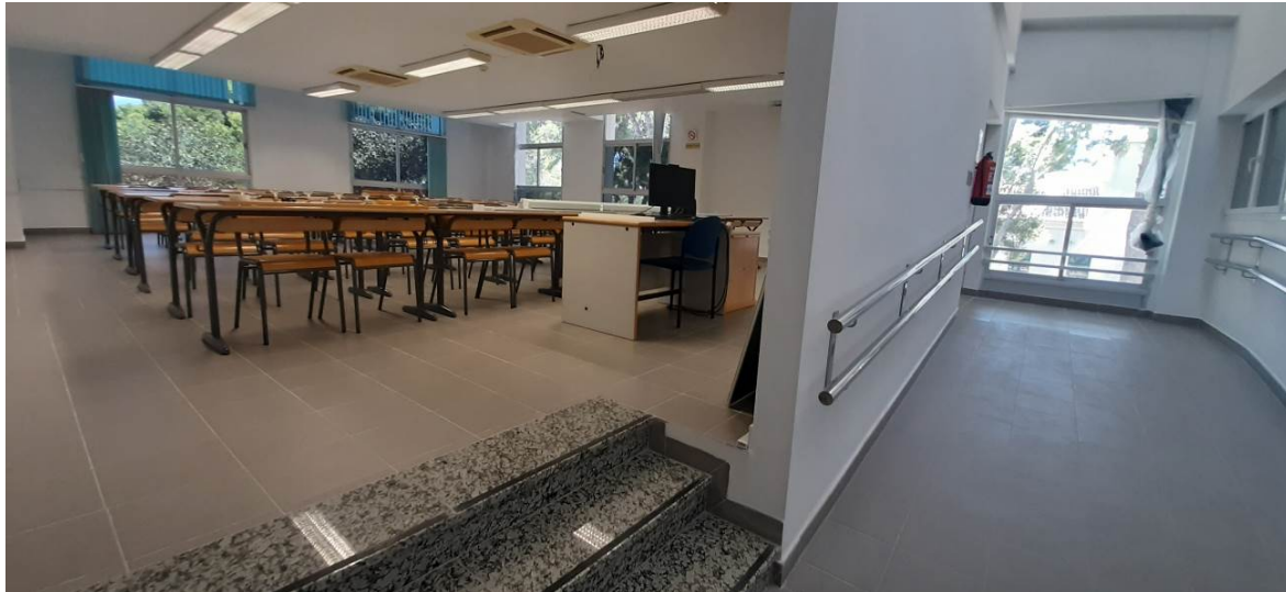
Nivelación del aula a un mismo nivel y ejecución de una rampa de acceso según las normas de accesibilidad
