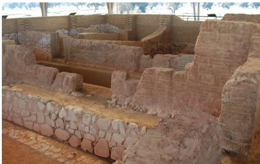
Figura 23. Conjuntos de muros de adobes en Cancho Roano (foto: autores).
