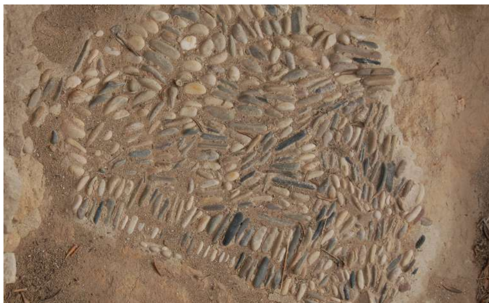
Figura 42. Empedrado a base de cantos de río dispuestos verticalmente en Cástulo (Linares) (foto: autores).
