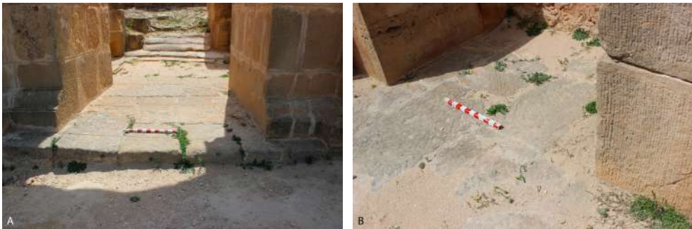
Figure 3. Amphithéâtre, lignes incisées sur le soubassement marquant la limite des piles de la façade vers l'extérieur (A) et l'intérieur (B).
