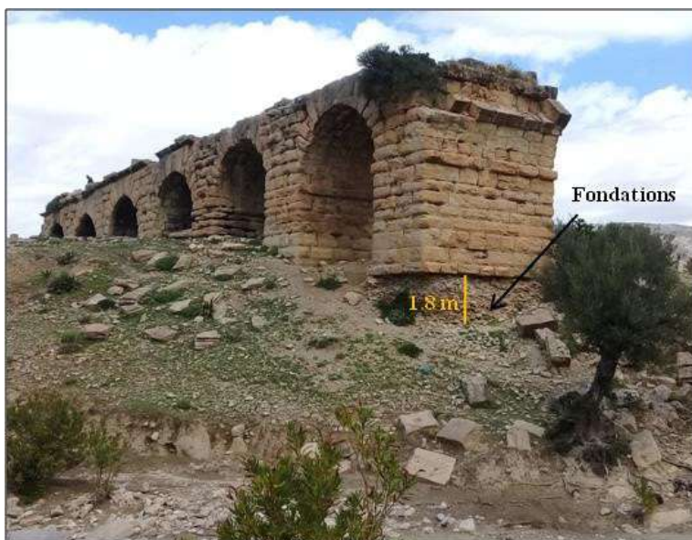
Figure 14. Vue sud de la sixième pile. Le sommet de la fondation domine le fond du lit actuel d'environ 6 mètres témoignant de l'importance de l'entaille linéaire [cliché N. Fehri, avril 2019].
