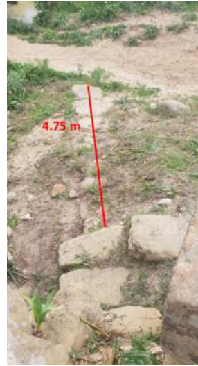
Figure 24. Vue de l'éventuel mur de guidage depuis la pile ouest.
