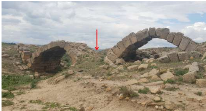
Figure 29. Vue de la pile est : façade sud-ouest.
