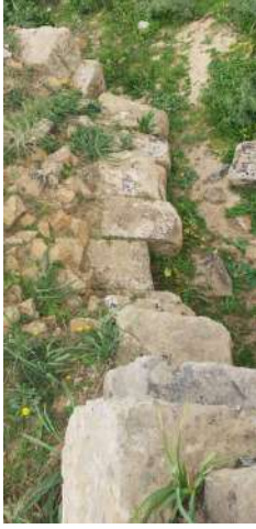
Figure 26. Vue prise au-dessus de la pile montrant la technique de construction en pierre de taille avec le remplissage en blocage.
