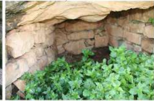
c. Dolmen construit avec des murs assisés en moyen appareil
