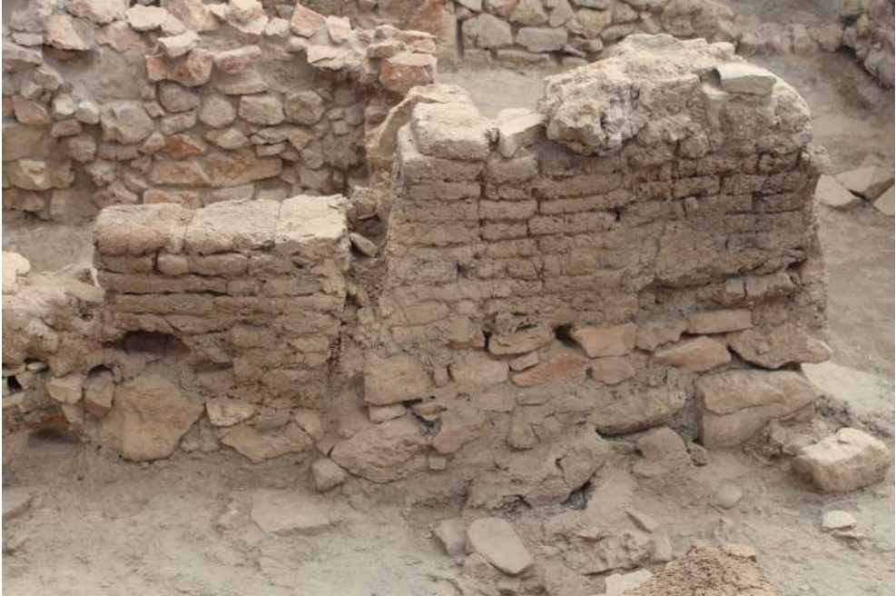
Figura 38. Muro de adobes en Libisosa. Compruébese la posición de los adobes dispuestos a perpiaño (foto: autores).
