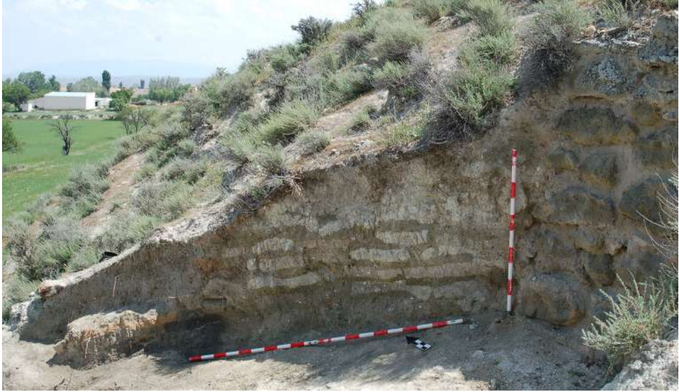
Figura 17. Muralla íbera de Basti , siglos VI-V a.C. Estructura de adobe construida contra el paramento externo de la muralla septentrional del oppidum (foto: Centro de Estudios de Arqueología Bastetana).
