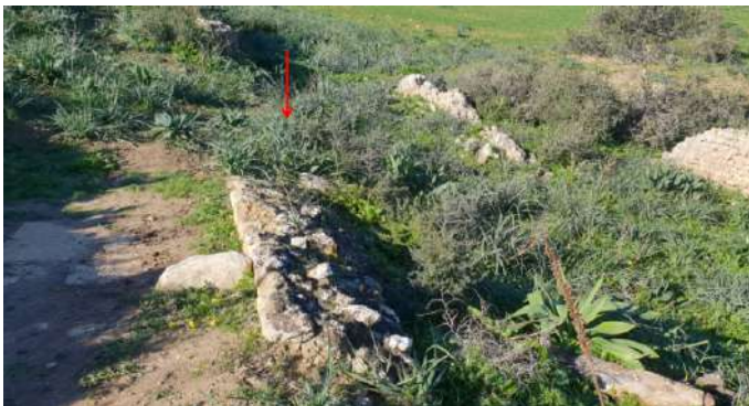
Figure 33. Vestiges de la culée nord de la rive ouest.
