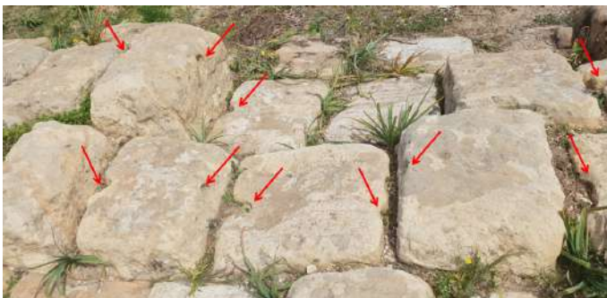
Figure 22. Les traces des trous de louve sur les blocs de pierre de taille.
