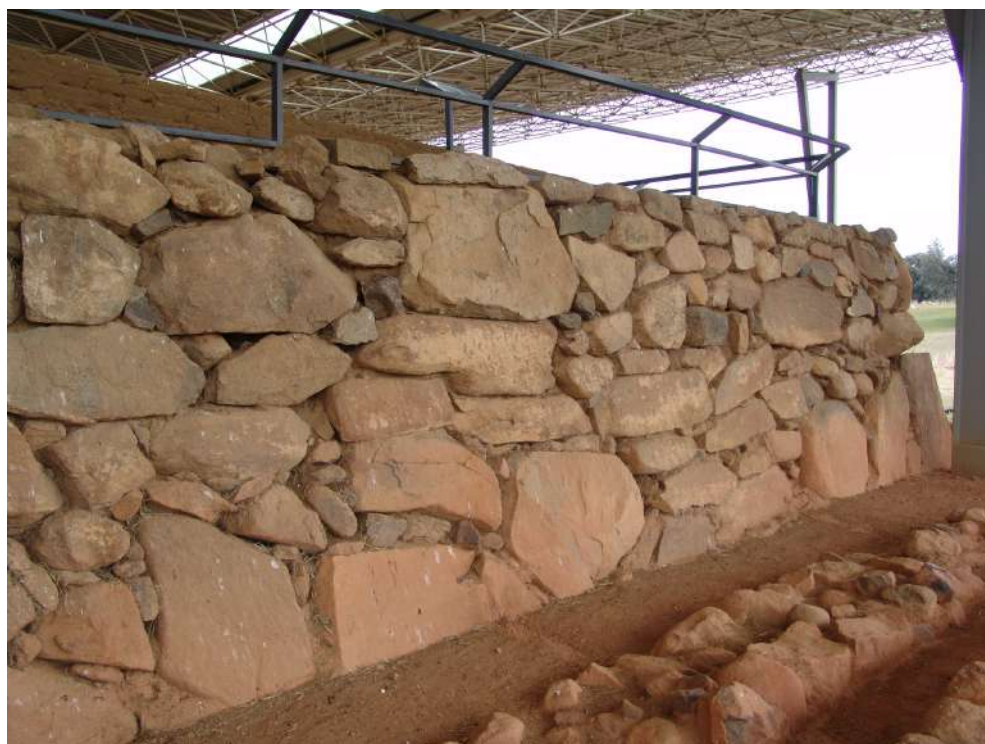
Figura 21. Muro de grandes bloques en Cancho Roano (foto: autores).
