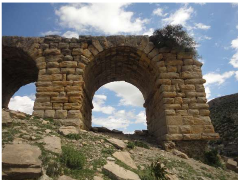
Figure 15. Détails de la façade sud-ouest des piles n°6 et n°7 et de l'arche n°6. [cliché S. Badri, avril 2019]
