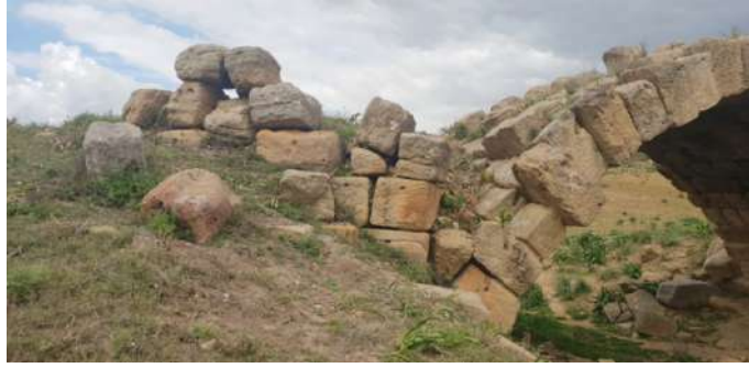
Figure 27. Vue de la pile ouest : façade sud-ouest.
