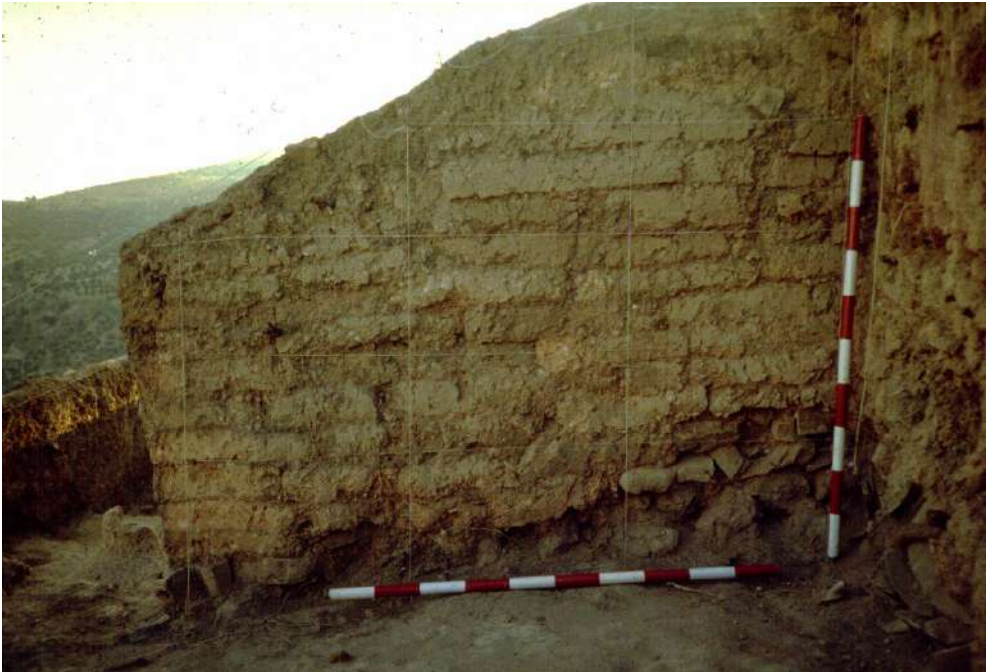
Figura 39. Muro de adobes en el Cerro de la Cruz (Quesada & Muñiz 2010: fig. 12).
