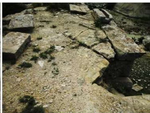
Figure 20. Dallage du tablier délimité par la corniche de couronnement. [cliché M. Grira, avril 2019].
