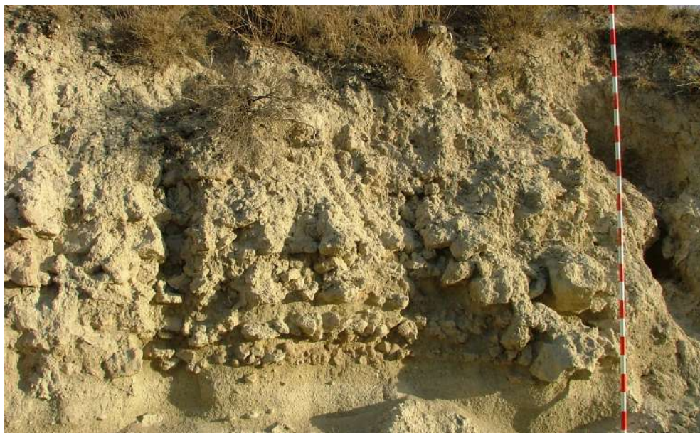
Figura 15. Muralla íbera de Basti , siglos VI-V a.C. Relleno interno de un bastión de planta cuadrada, compuesto de alternancia de capas de tierra y detritos de extracción y careado de los mampuestos, roto por la construcción de un camino (foto: Centro de Estudios de Arqueología Bastetana).
