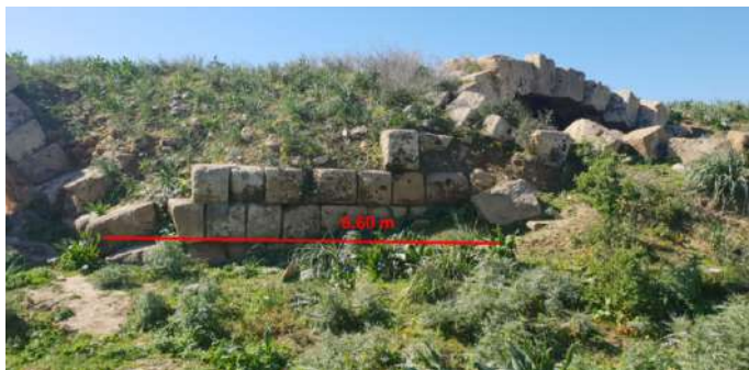
Figure 25. Vue de la pile ouest : façade nord-est.
