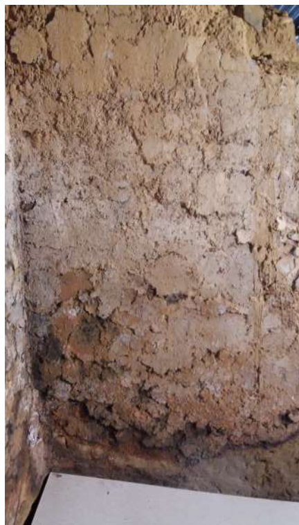
Figura 27. Recubrimiento de las paredes de adobe en El Turuñuelo (foto: autores).
