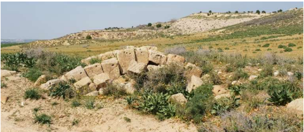
Figure 19. Arche ouest : façade sud-ouest.
