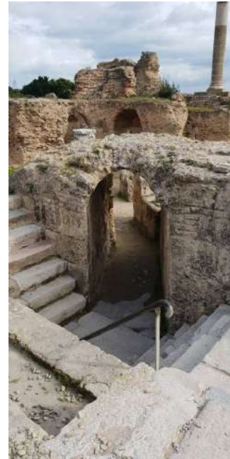
Figure 47. Voûte biaisée aux thermes d'Antonin à Carthage.
