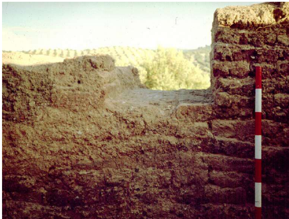
Figura 45. Ventana en uno de los muros de adobe en el Cerro de la Cruz (Quesada, et al. , 2010: fig. 3).
