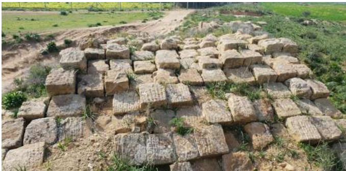
Figure 21. Vue de l'extrados de l'arche centrale.
