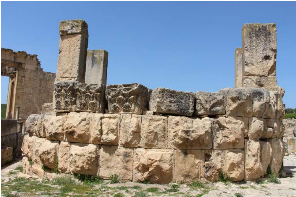
Figure 6. Le podium en opus quadratum à bossages du temple de Pietas (cliché de l'auteur).
