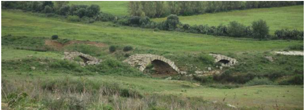
Figure 13. Vue d'ensemble du pont.
