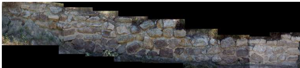
Figura 14. Muralla íbera de Basti , siglos VI-V a.C. Las piedras son de una sola cantera, recortada y paramentadas para formar parte de la misma. Los mampuestos se disponen en pseudohiladas. A la derecha se observa la jamba de una pequeña poterna (foto: Centro de Estudios de Arqueología Bastetana).
