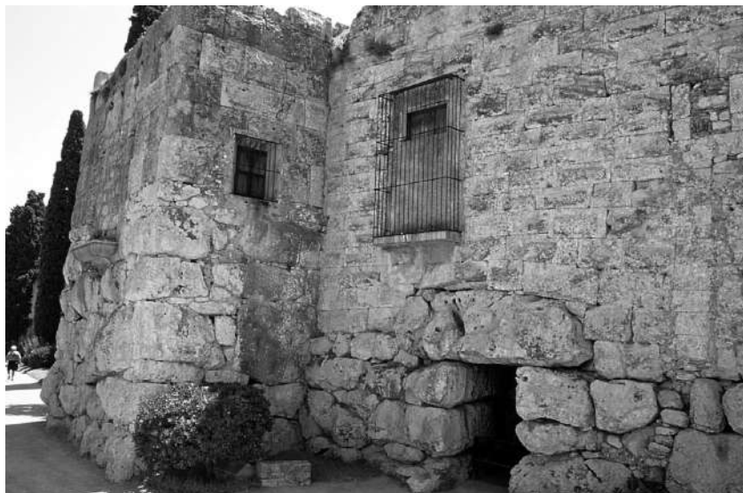
Figura 4. Vista de la Torre del Cabiscol con zócalo alto de megalitos a la que se adosa un lienzo con zócalo bajo de la segunda fase de la muralla. Foto Joaquín Ruíz de Arbulo.
