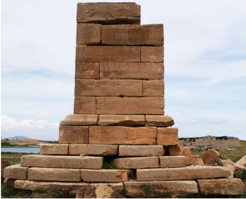
Figure 9. Façade ouest du mausolée de Henchir El Ksar.
