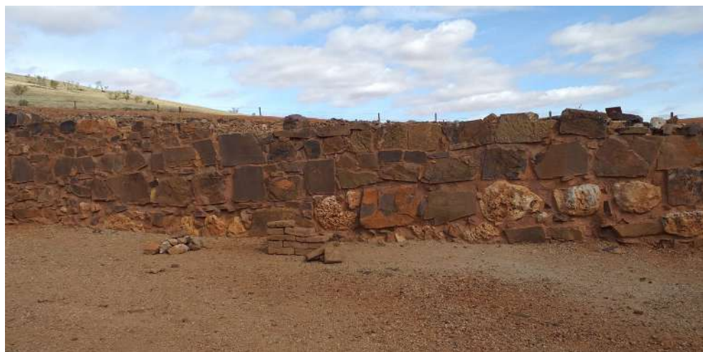
Figura 19. Muralla íbera de Cerro de las Cabezas, siglos V-IV a.C. Grandes bloques dispuestos en pseudohiladas en el paramento externo junto a la puerta meridional. (foto: autores).
