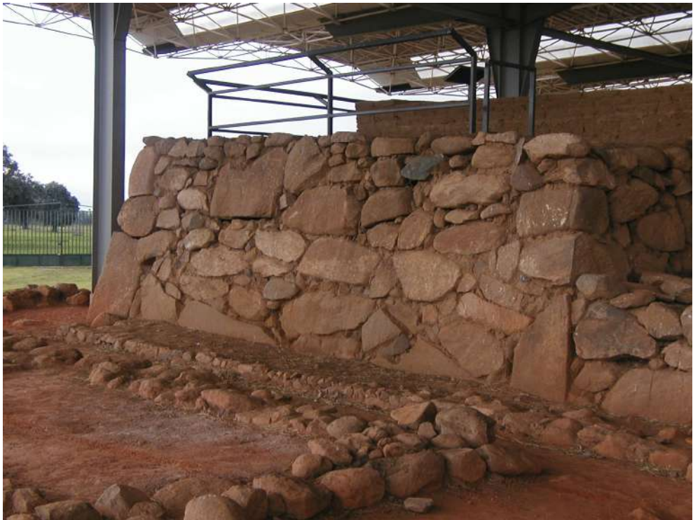
Figura 22. Cancho Roano. Muro en talud con refuerzo en las esquinas mediante mampuestos de grandes dimensiones colocados en vertical /foto: autores).
