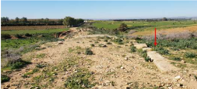
Figure 31. Vestiges de la culée nord de la rive est.
