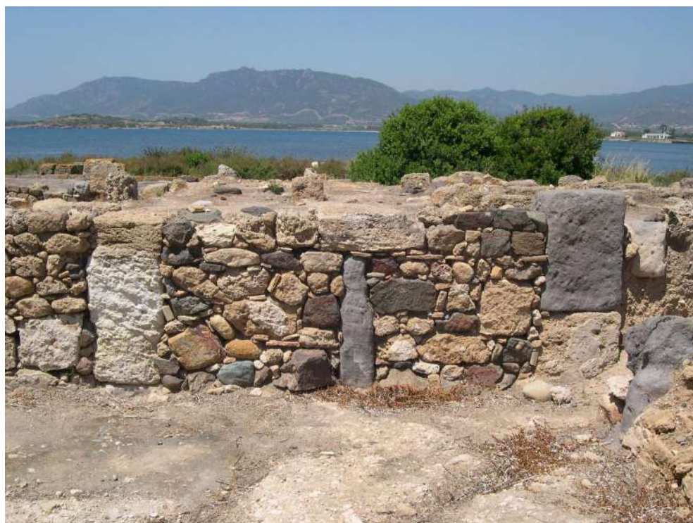
Figura 13. Muro de pilares de una casa de Nora (Cerdeña).
