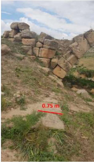
Figure 23. Vue de l'éventuel mur de guidage en amont du pont.
