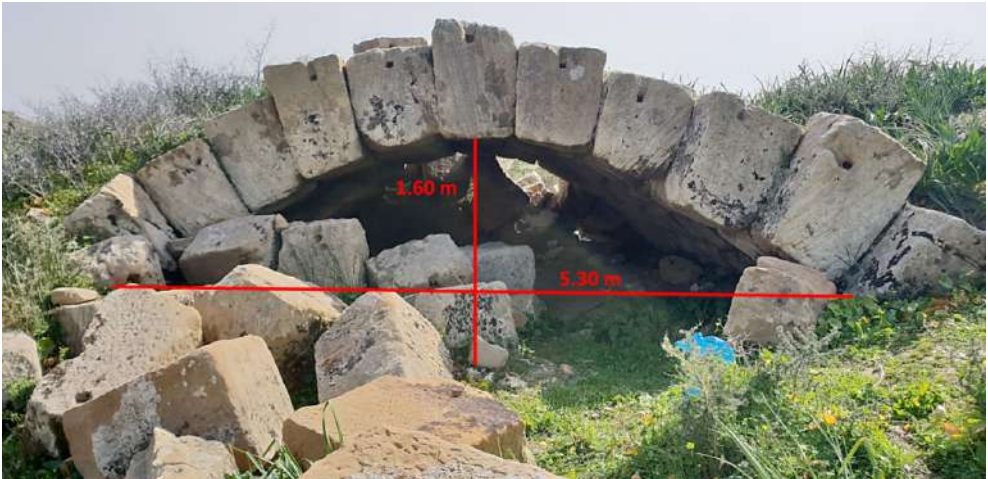
Figure 18. Arche ouest : façade nord-est.
