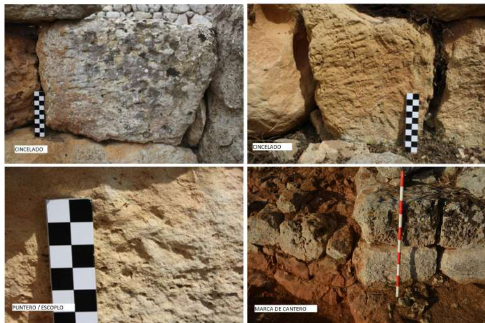
Figura 8. Huellas del empleo de herramientas de talla y marcas de cantería. Poblados de Torralba y Son Catlar (Menorca).
