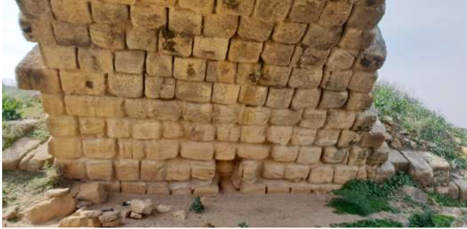
Figure 20. Vue de l'intrados de l'arche centrale.
