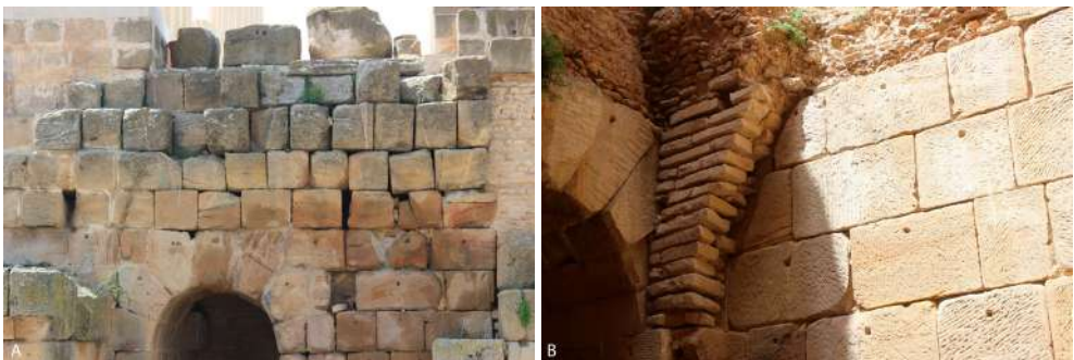
Figure 7. Capitole, mortaises en arc de cercle précisant la hauteur et la forme de la voûte au niveau supérieur (A) et au niveau inférieur du podium (B)
