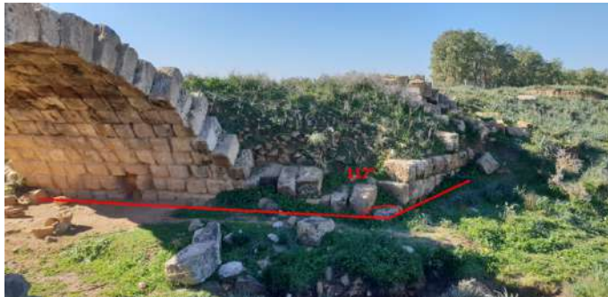
Figure 43. L'angle nord entre la pile ouest et l'arche principale.
