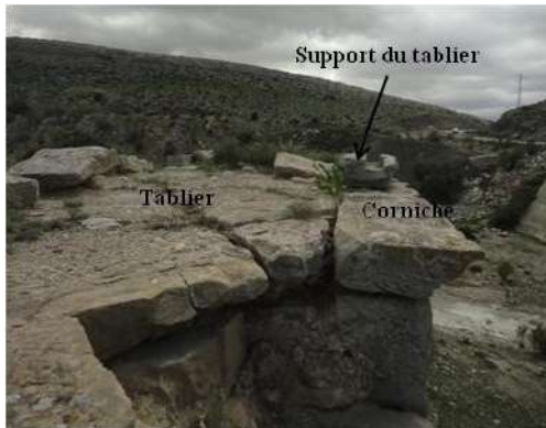
Figure 17. Corniche de couronnement, tablier et support du parapet. [cliché Ben Abdallah, avril 2019].
