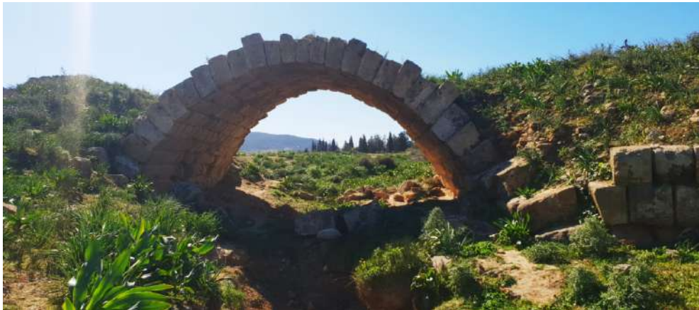
Figure 15. Arche centrale : façade nord-est.
