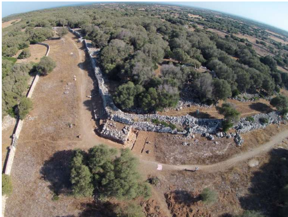
Figura 9. Vista aérea del sector norte de la muralla de Son Catlar.
