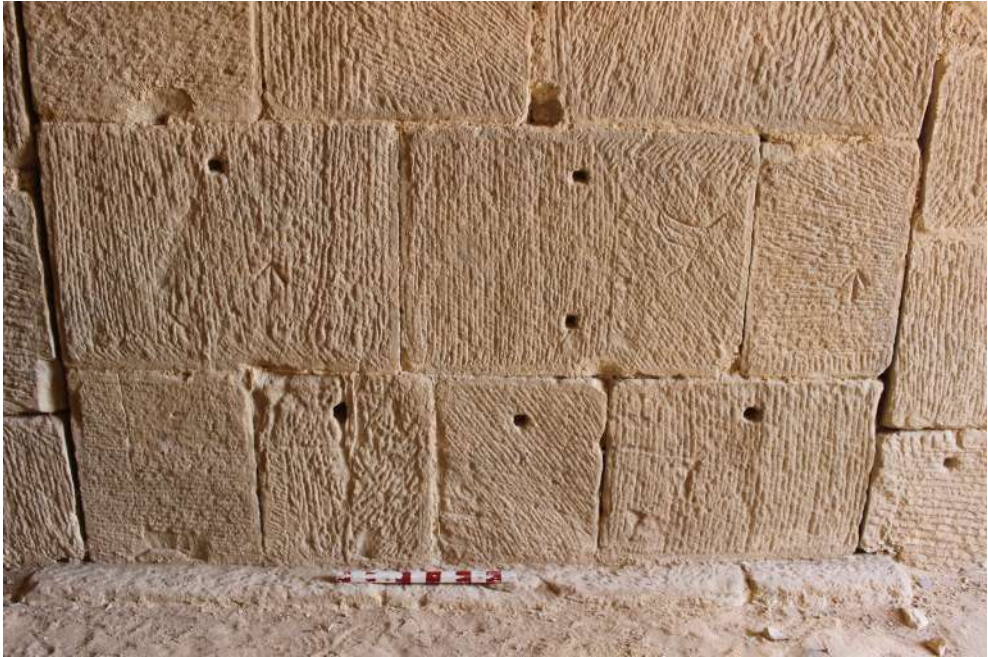
Figure 6. Capitole, une paire de flèches indiquant l'emplacement d'une des colonnes de la façade du temple principal.
