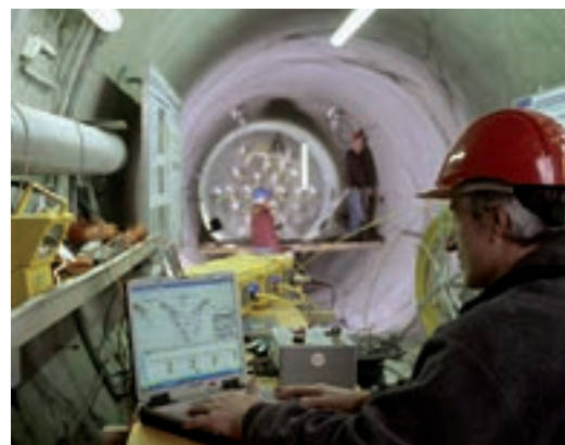
Seismische Messungen im Grimsel-Felslabor.
