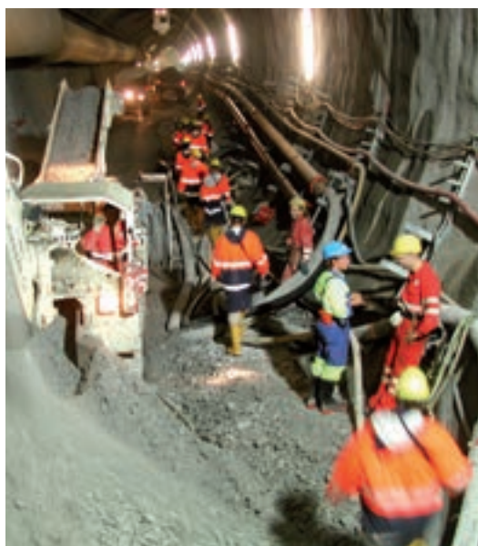
Exkursion auf einer Baustelle des Gotthard-Basistunnels.
