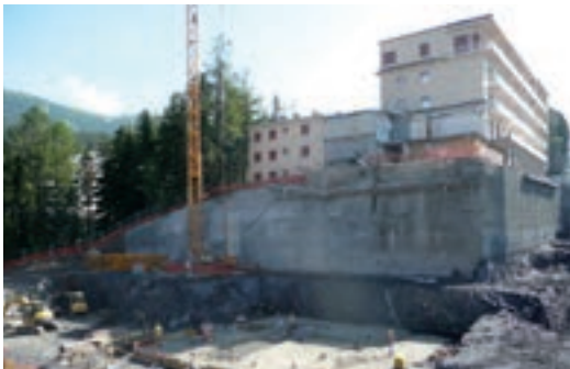
Sicherheit für komplexe Grabungen – mit einer Stützmauer aus Spritzbeton
