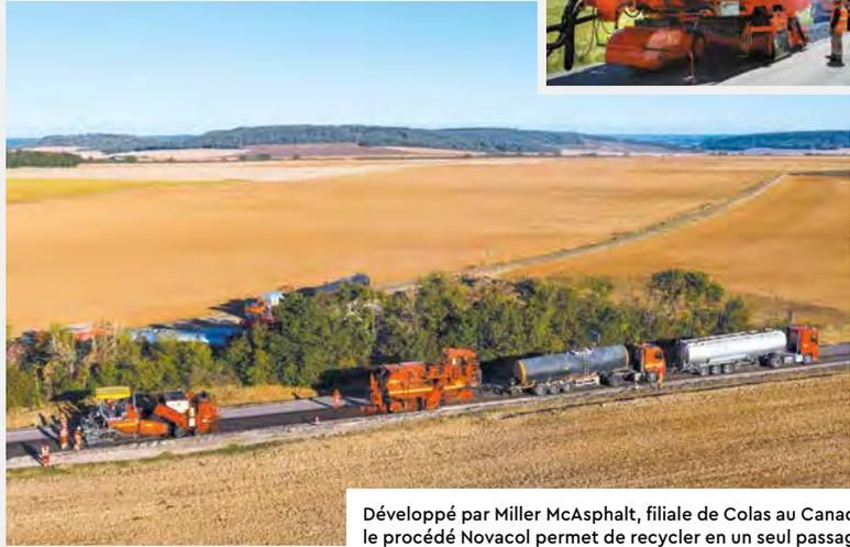
Développé par Miller McAsphalt, filiale de Colas au Canada, le procédé Novacol permet de recycler en un seul passage les chaussées usagées et ainsi de réduire les émissions de CO<sub>2</sub> et l'utilisation de matières premières. Ici, utilisation de Novacol sur un chantier de Nouvelle-Aquitaine
