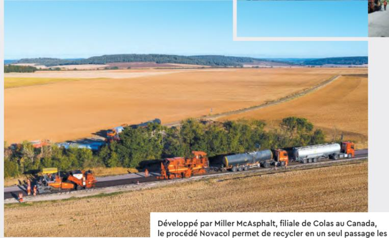
Développé par Miller McAsphalt, filiale de Colas au Canada, le procédé Novacol permet de recycler en un seul passage les chaussées usagées et ainsi de réduire les émissions de CO<sub>2</sub> et l'utilisation de matières premières. Ici, utilisation de Novacol sur un chantier de Nouvelle-Aquitaine
