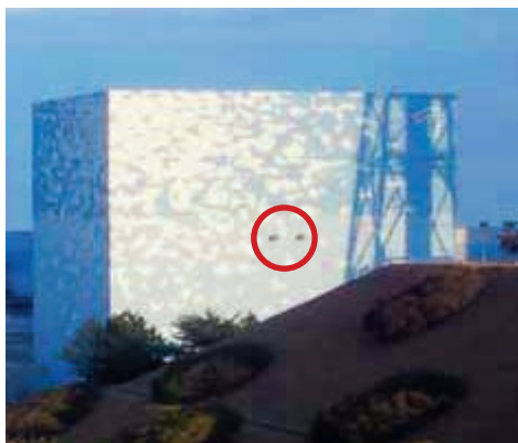
Abbildung 12: Abblaseleitungen des IC (Quelle: TEPCO [7], Attachment 2)
