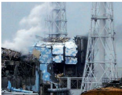
Abbildung 52: Block 4 nach der Wasserstoff- explosion (Quelle: TEPCO [24])
