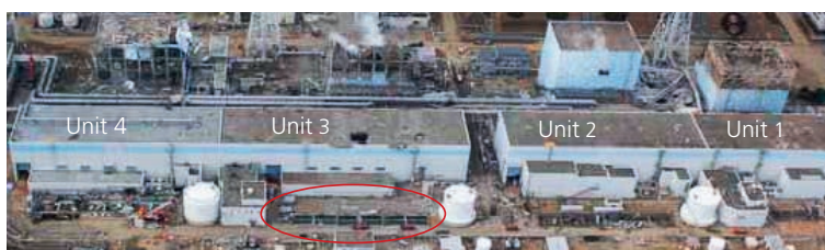
Abbildung 20: Kühlwasser- aufnahmebecken vor Block 3 (Quelle: TEPCO [7], Attachment 2)
