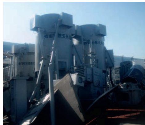
Abbildung 10: Kühlwasserpumpenhaus für Meerwasser (Quelle: TEPCO [24])
