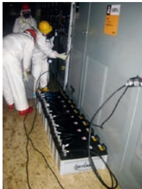
Abbildung 34: Arbeiten in einem elektrischen Schaltraum des Blocks 2 (Quelle: TEPCO)
