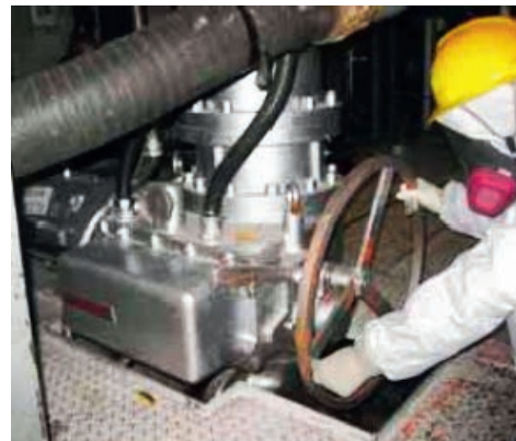
Abbildung 27: Beispiel für einen Einsatz an einem RHR-Ventil (Foto von Block 5 mit Beleuchtung) (Quelle: TEPCO [7], Attachment 2, S. 87)
