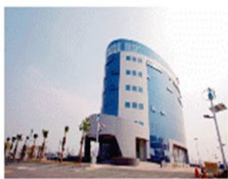
高明貨櫃碼頭行政大樓屋頂配備太陽能光電板
