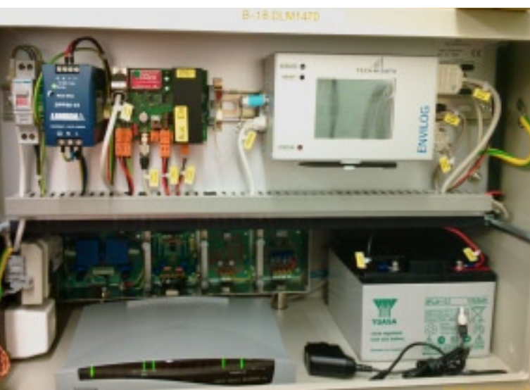
Darstellung B.2: Neuer Messwertsender im Messelektronikkasten
