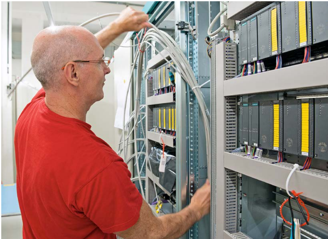
Verlegen neuer Kabel für die neuen Leittechniksschränke im Schaltanlagegebäude Foto: KKG
