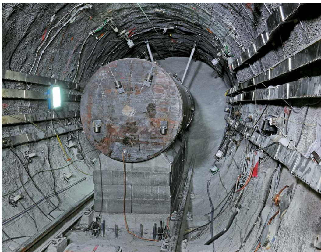
Einbau des Testbehälters in den Versuchsstollen. Foto: Comet
