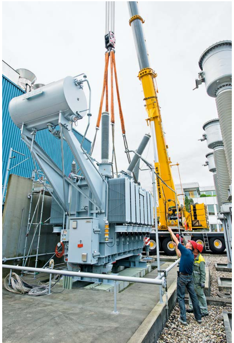
Montage Fremdeinspeisettransformator 220kV Foto: KKG
