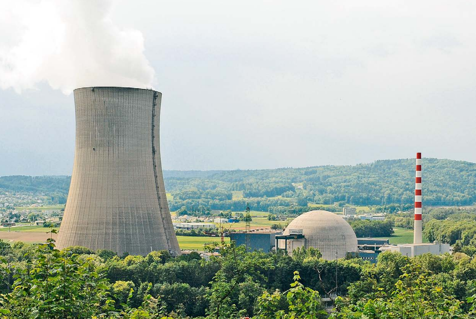
Kernkraftwerk Gösgen. Foto: KKG
