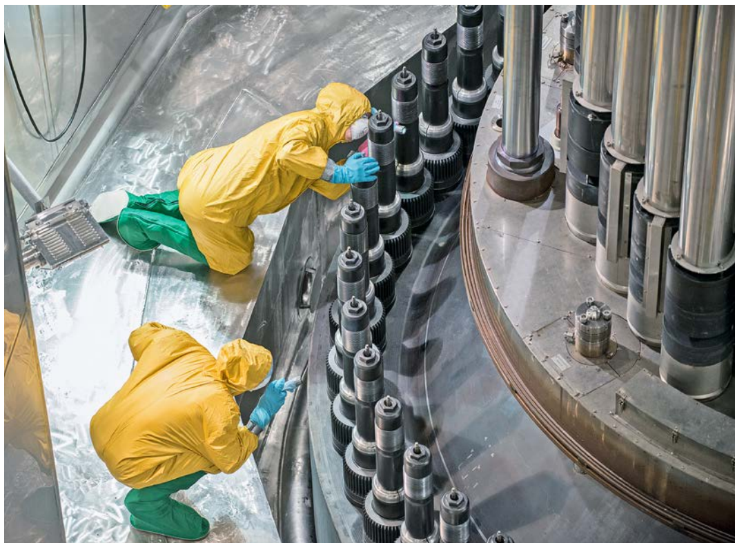
Während der Druckprobe: Der Reaktordruckbehälter wird auf Leckagen untersucht. Foto: KKG
