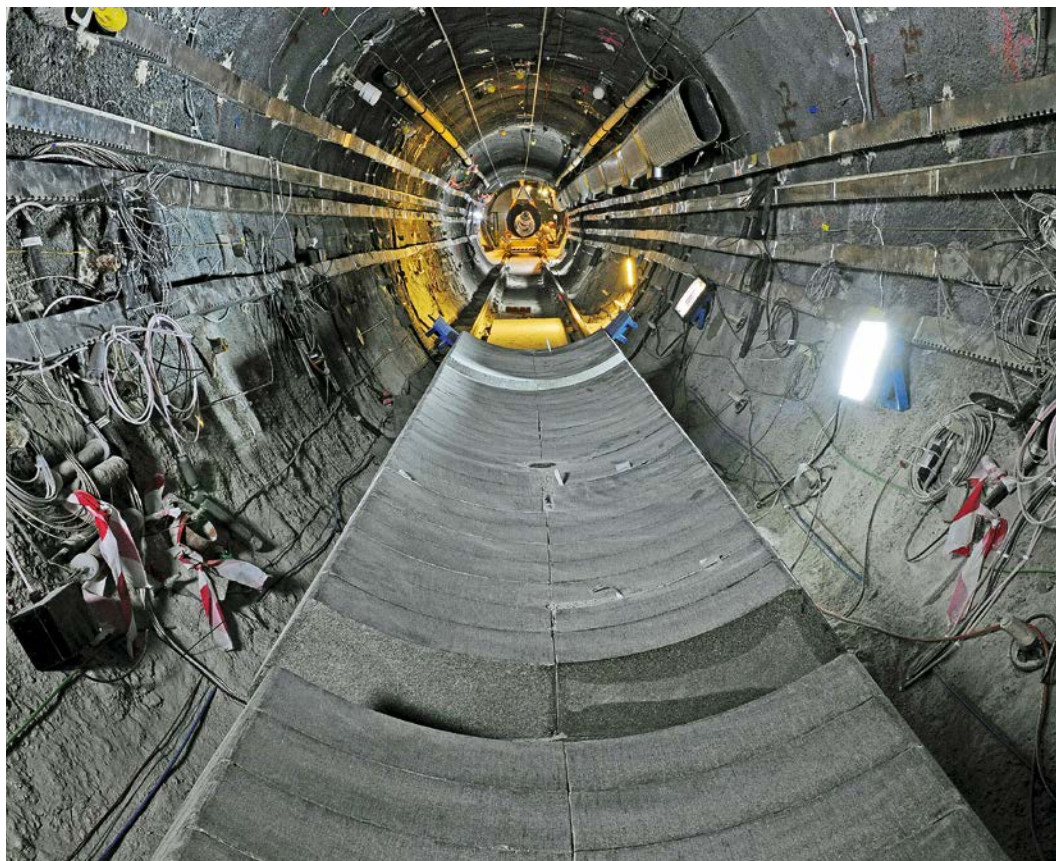
Vorbereitung des Stollens für den Wärmetest. Foto: Comet
