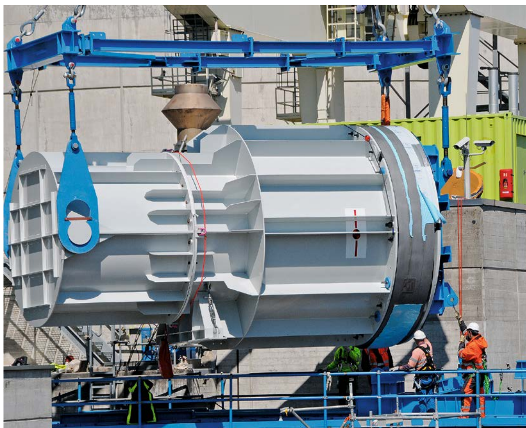
Neuer RDB-Deckel in Transportverpackung. Foto: KKB
