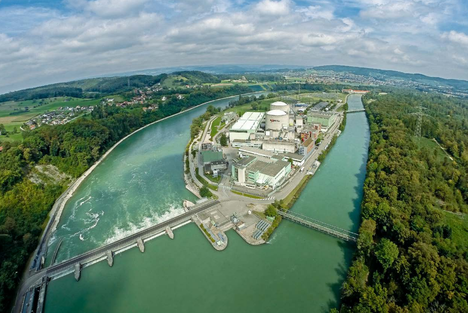
Kernkraftwerk Beznau. Foto: KKB
