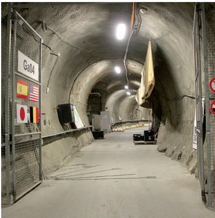
Stollen im Felslabor Mont Terri. Foto: CCV.
