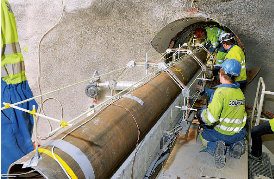
Einbau einer Versuchsarmatur im Felslabor. Foto: CCV.
