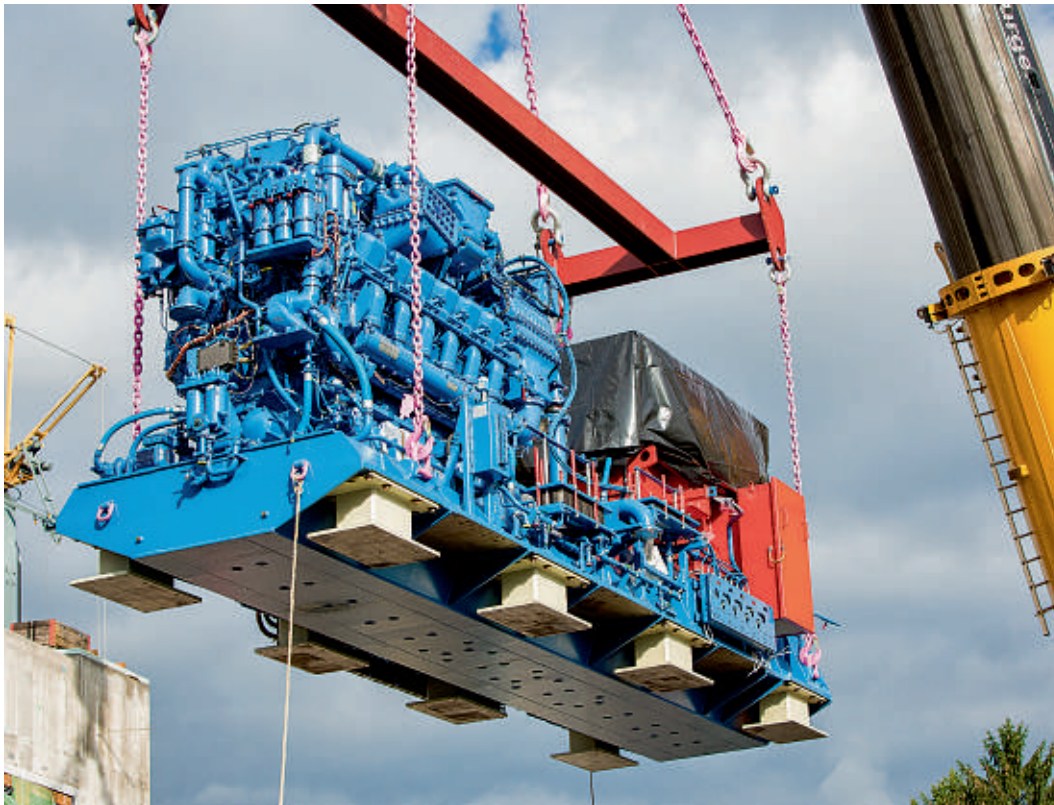
Neuer Dieselgenerator für AUTANOVE. Foto: KKB.
