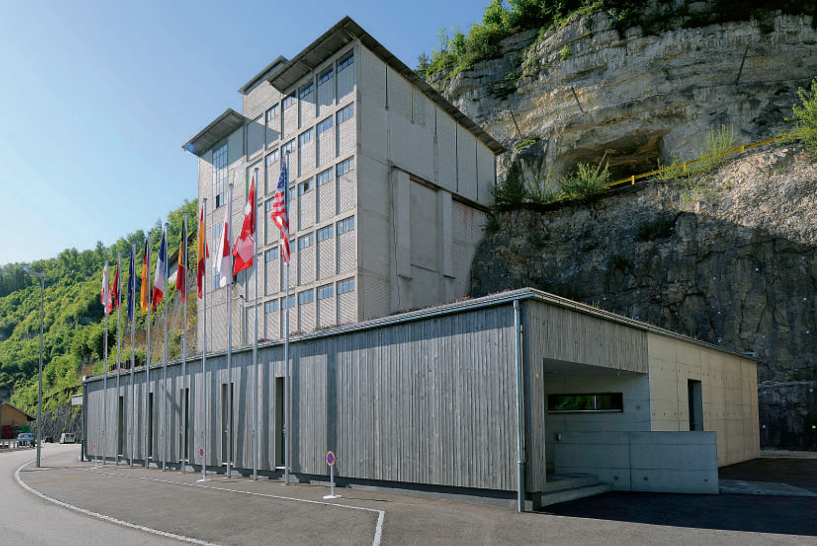
Aussenansicht des Besucherzentrums beim Felslabor Mont Terri. Foto: CCV.
