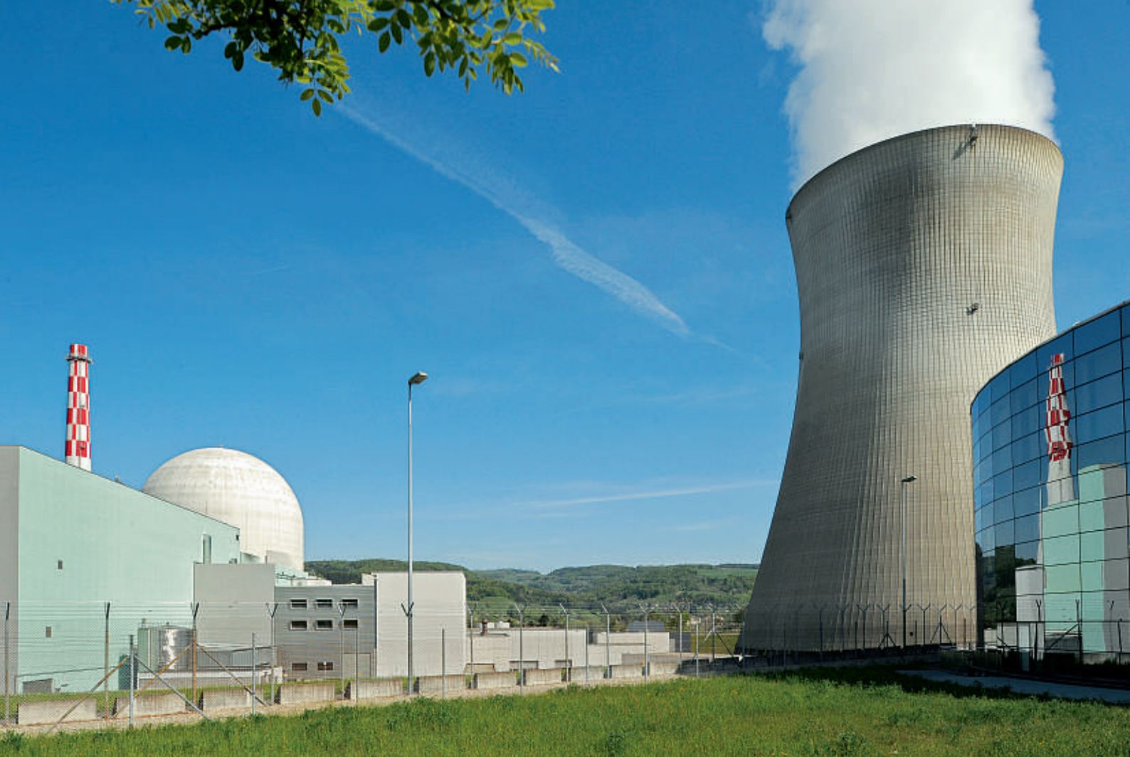
Kernkraftwerk Leibstadt. Foto: ENSI.
