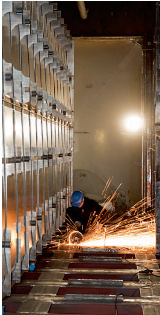
Einbau eines Vorkühlers am Kondensator. Foto: KKG.
