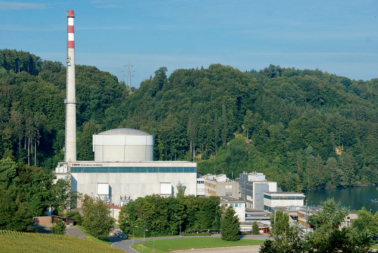
Kernkraftwerk Mühleberg. Foto: ENSI.
