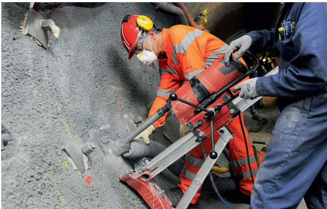
Geneigte Bohrungen für Messinstrumente. Foto: Comet.
