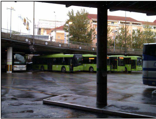
Figur 13: Baksiden av Oslo Bussterminal, med reguleringsplasser. (Sett mot østre ramper fra Nylandsveien).
