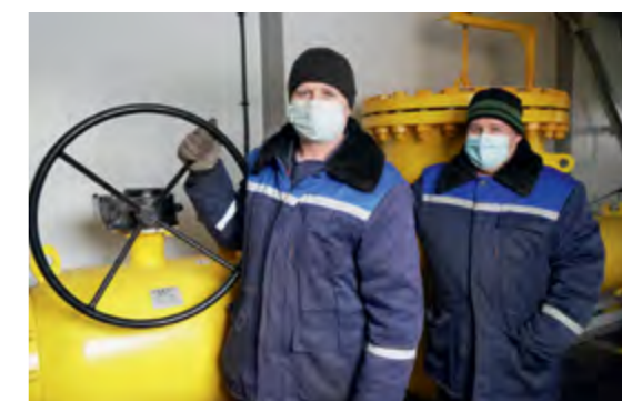
< Слесари по ремонту и эксплуатации газового оборудования Коломенского завода Валерий Викторович Шамарин и Андрей Владимирович Горшечников проверяют оборудование коммерческого узла учета газа
