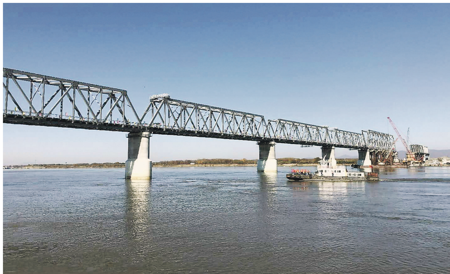
Монтаж последней стальной балки главного пролета Тунцзянского китайско-российского моста длиной 144 метра ознаменовал полное завершение строительных работ китайской стороной
