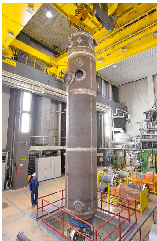
Einbau eines Niederdruck-Vorwärmers. Foto: KKG
