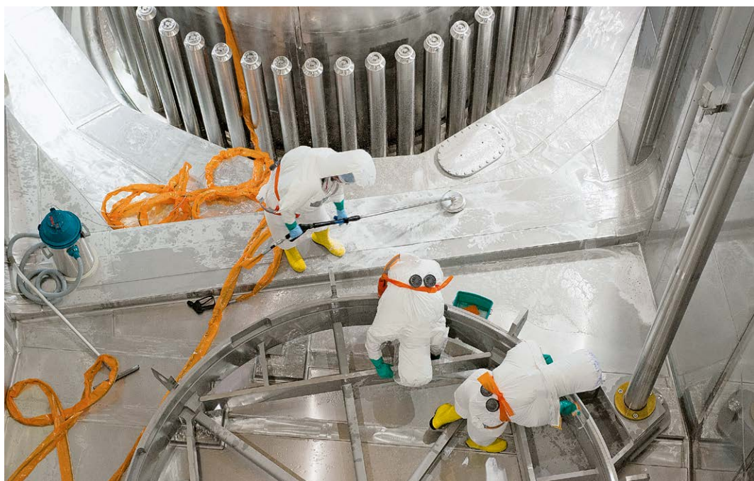
Reinigung der Reaktorgube. Foto: KKG
