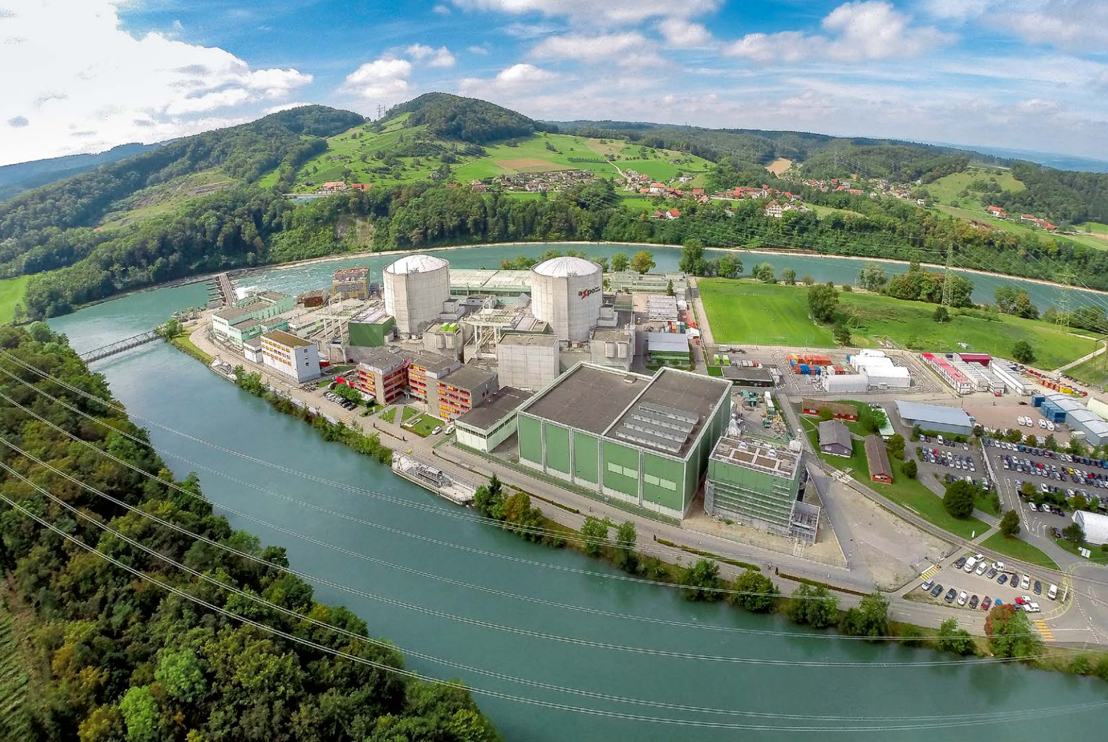
Kernkraftwerk Beznau. Foto: KKB
