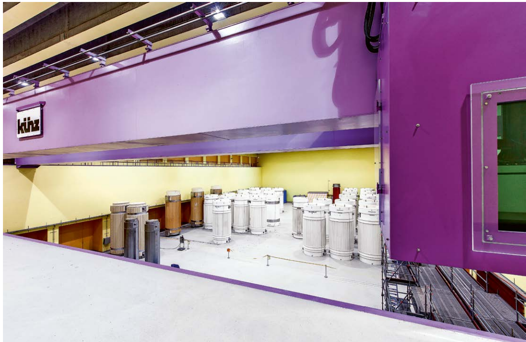
Behälterlagerhalle mit Kran. Foto: Zwilag
