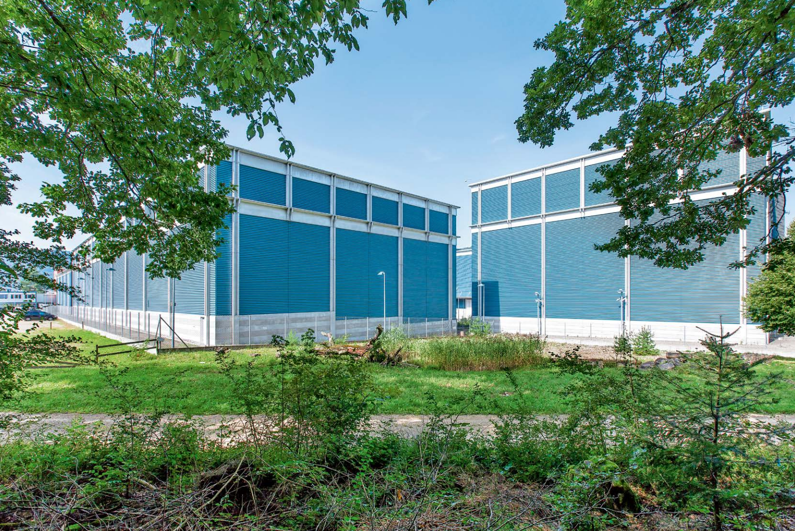
Zentrales Zwischenlager Würenlingen. Foto: Zwiilag
