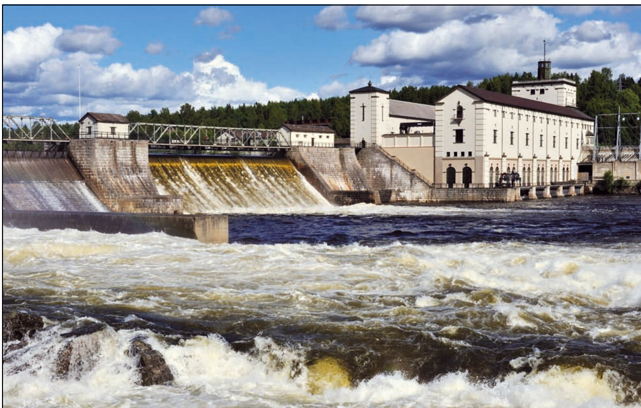
Figur 2.6 Demning i elv, Rånåsfoss kraftverk
