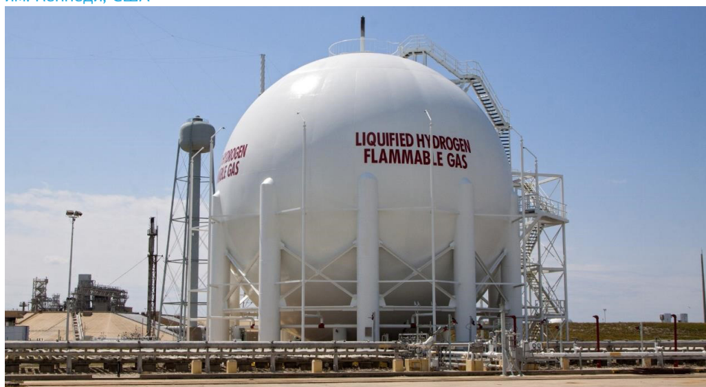
Рисунок 24 Хранилище сжиженного водорода 3200 м 3 в Космическом центре им. Кеннеди, США
