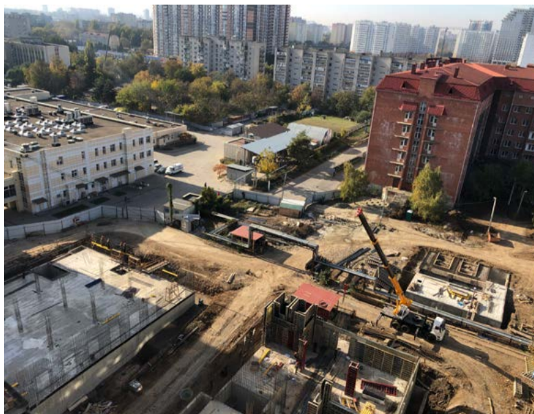
Строительство первого этапа второй очереди идёт, несмотря на пандемию.
