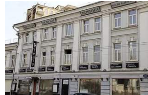
ТЕАТР НА ПОКРОВКЕ (КАПИТАЛЬНЫЙ РЕМОНТ ПОМЕЩЕНИЙ)
