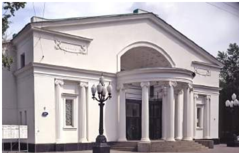
ТЕАТР «СОВРЕМЕНИК» (РЕМОНТНО-РЕСТАВРАЦИОННЫЕ РАБОТЫ)
