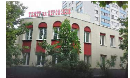
ТЕАТР НА ПЕРОВСКОЙ (КАПИТАЛЬНЫЙ РЕМОНТ ПОМЕЩЕНИЙ ТЕАТРА)
