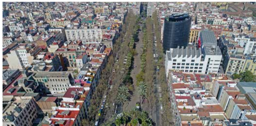
Imatge aèria de la Ramla del Raval // Font: Ajuntament de Barcelona
