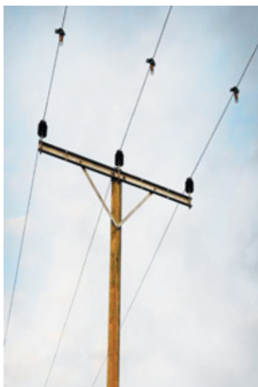
Индикаторы, установленные на фазу
