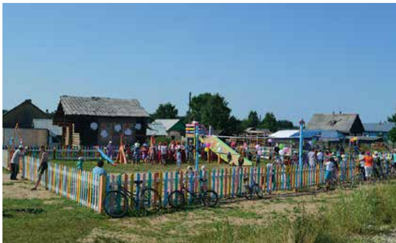
Строительство детской спортплощадки в д. Гурган, Республика Коми
