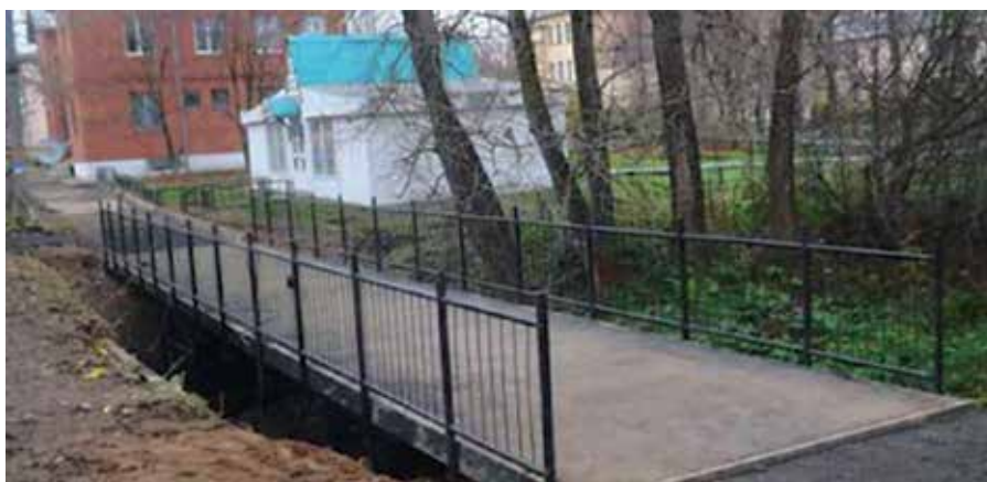
Ремонт пешеходного моста в Грязовецком районе, Вологодская область
