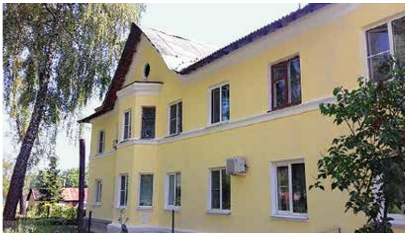
Ремонт фасада жилого дома № 22 по ул. Индустриальная, р.п. Первомайский (Щекинский район), Тульская область
