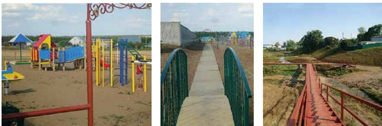
Строительство детской и спортивной площадок в Сабинском муниципальном районе Республики Татарстан
