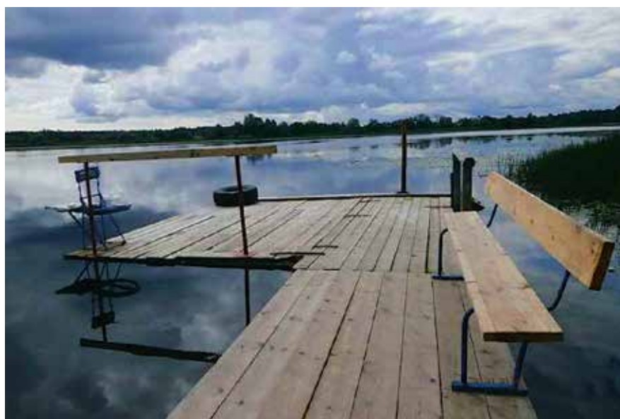
Ремонт спуска-подхода к реке и постройка платома в Вашкинском районе, Вологодская область
