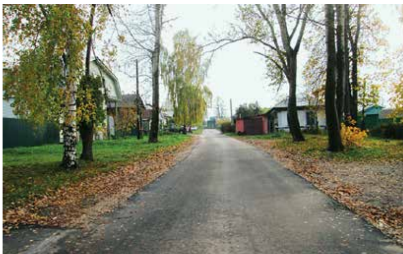
Ремонт автомобильной дороги г. Богородска, Нижегородская область
