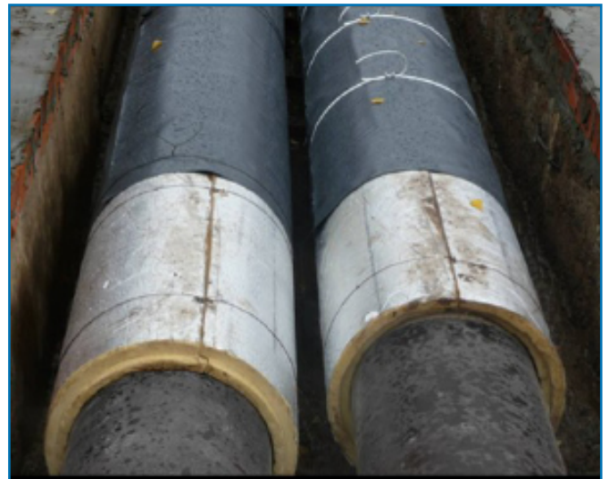
Рисунок 13. Реконструкция тепловой сети по ул. Красноармейская с использованием в качестве теплоизоляционного материала ППУ-скорлуп.
