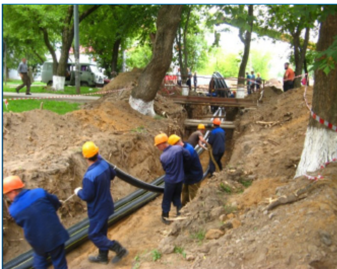
Рисунок 15. Монтаж трубопроводов из сшитого полиэтилена на объекте.
