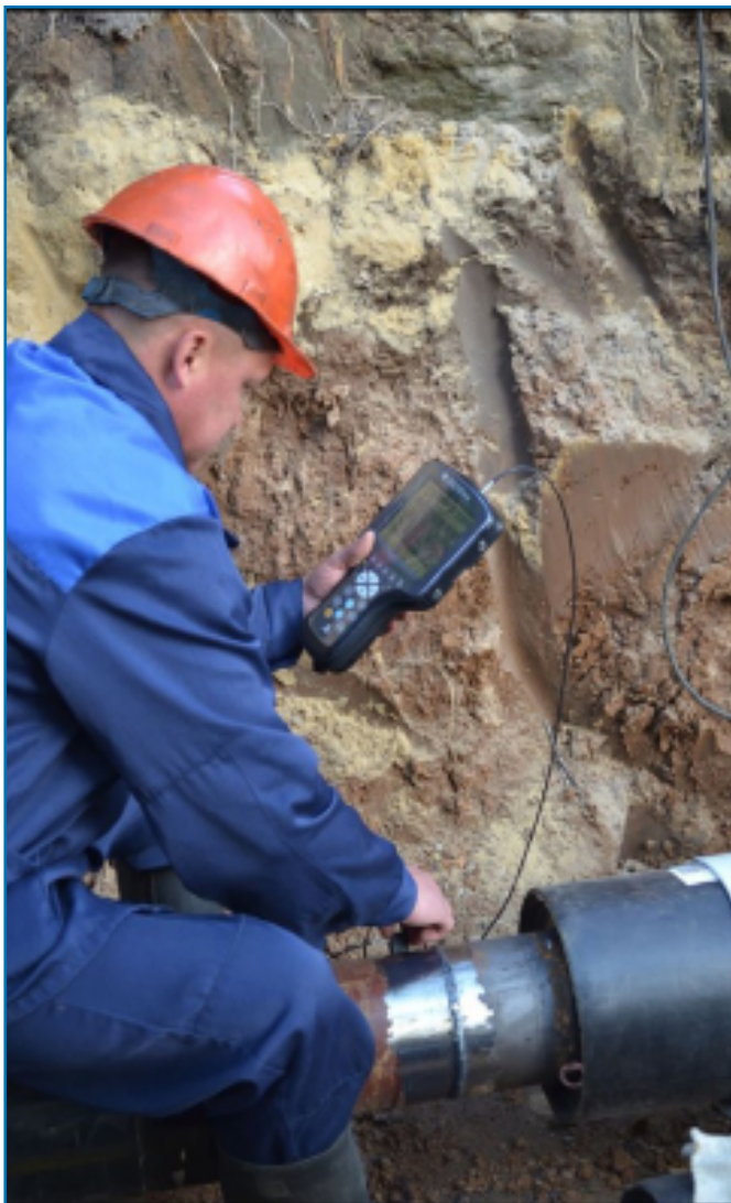
Рисунок 17. Входной контроль качества сварного шва.
