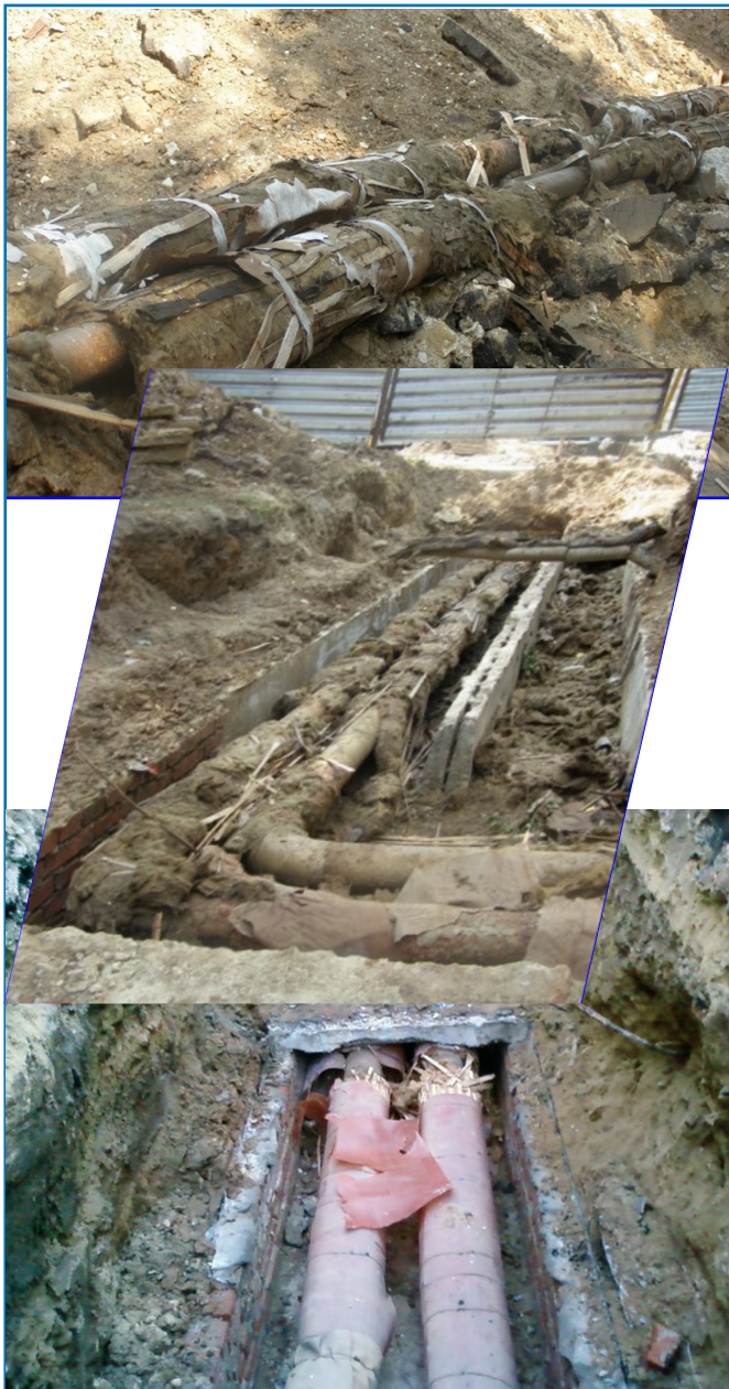
Рисунок 3. Состояние тепловых сетей, переданных в муниципальное управление.
