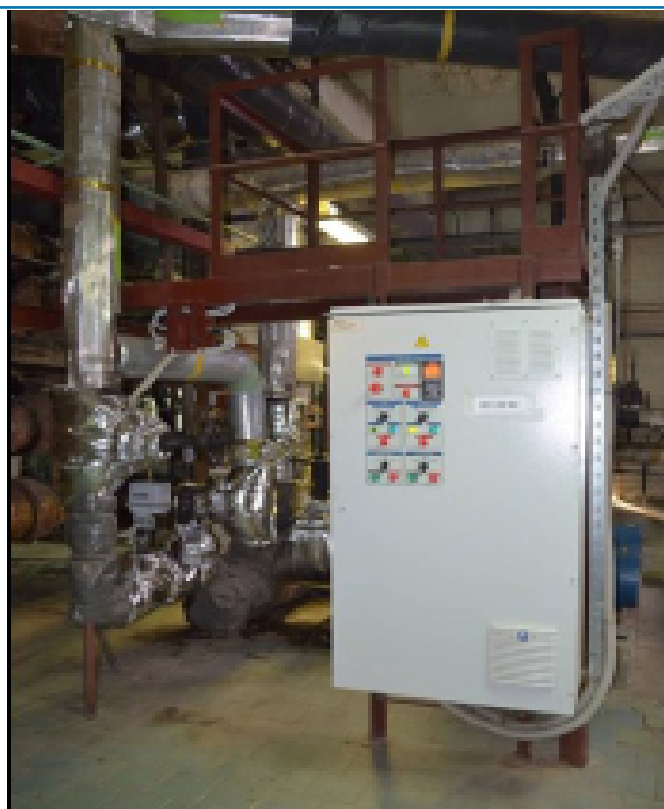
Рисунок 19. Диспетчерский пункт и мнемосхема автоматизированного ЦТП № 2..
