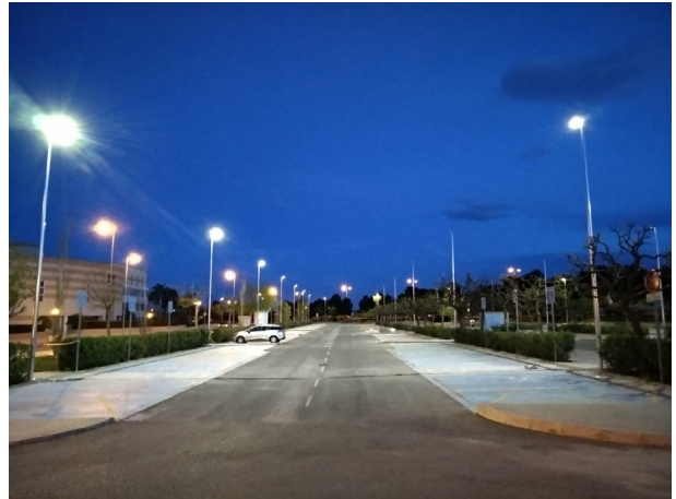
Con la nueva luminaria
