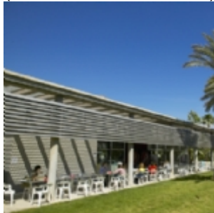
Cafetería La Terreta (zona comercial)
