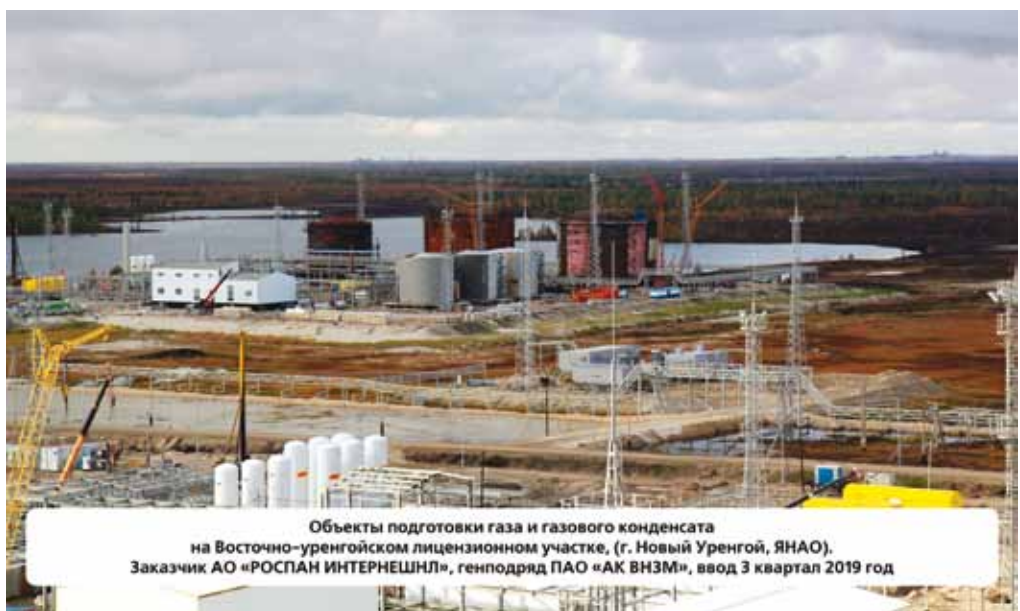
Объекты подготовки газа и газового конденсата на Восточно-уренгойском лицензионном участке, (г. Новый Уренгой, ЯНАО). Заказчик АО «РОСПАН ИНТЕРНЭШНЛ», генподряд ПАО «АК ВНЗМ», ввод 3 квартал 2019 год
