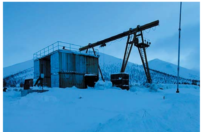
Рис. 2 Козловый кран на рельсовом ходу
