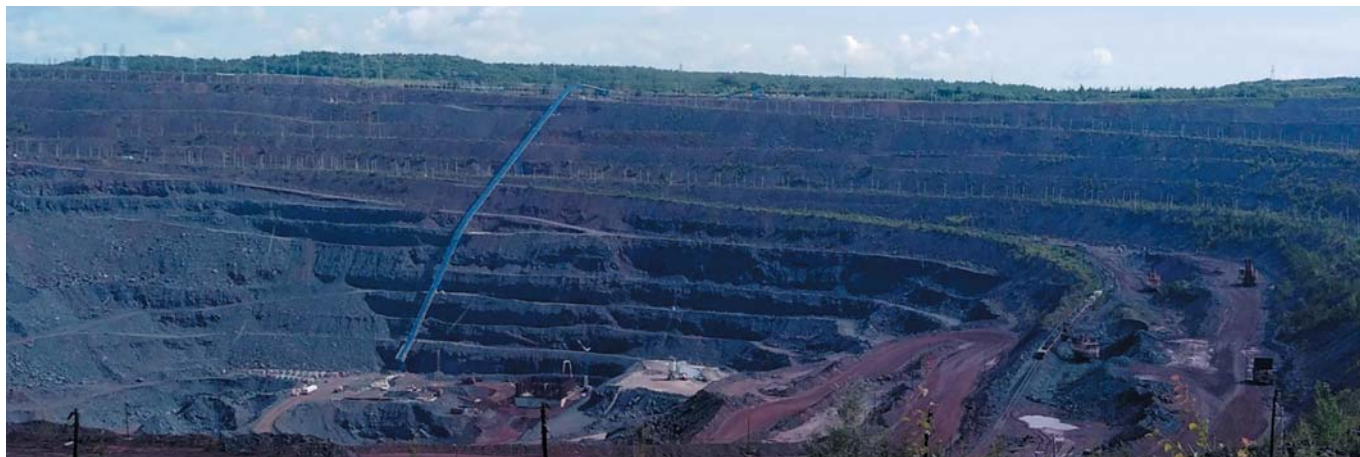
Рис. 1 Строительство крутонаклонного конвейера
