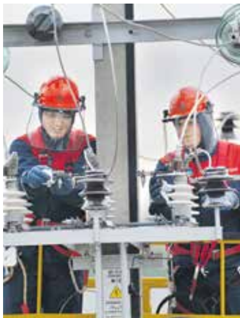
СЕРГЕЙ КОНДРАШОВ, МАСТЕР ЭКСПЛУАТАЦИОННОГО УЧАСТКА ВЛ 0,4–10 КВ КИНГИСЕППСКОГО РЭС ФИЛИАЛА ЛЕНЭНЕРГО — КИНГИСЕППСКИЕ ЭС
