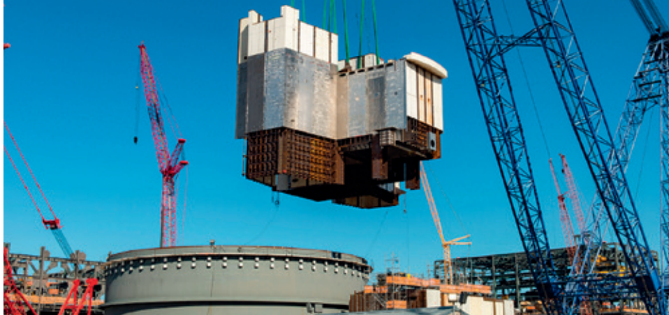
Centrale nucléaire de Vogtle unité 4 - AP1000, États-Unis, mise en place du module CA20 en août 2016. Georgia Power Company
