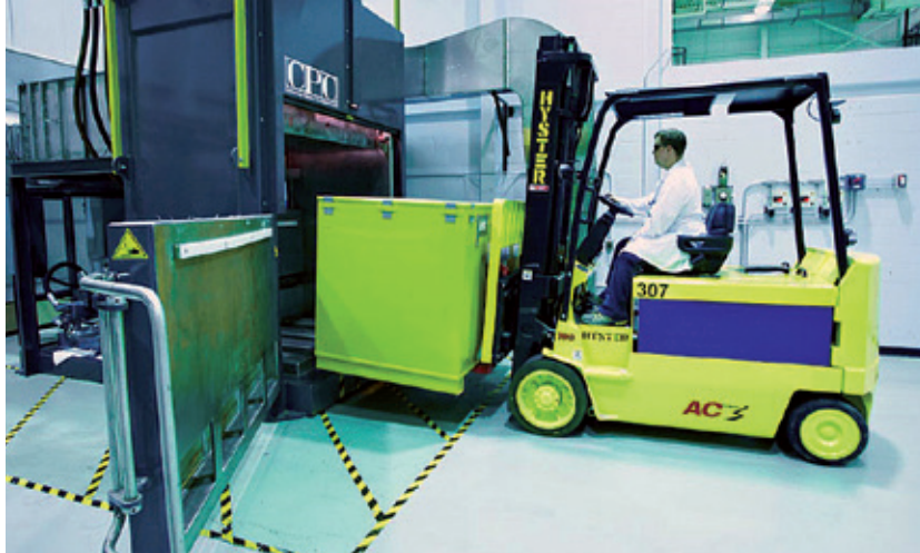
Démantèlement des laboratoires Whiteshell. Canada Nuclear Laboratories (LNC)
