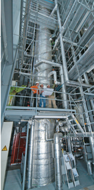
La cuve sous pression du réacteur PANDA. Institut Paul Scherrer, Suisse
