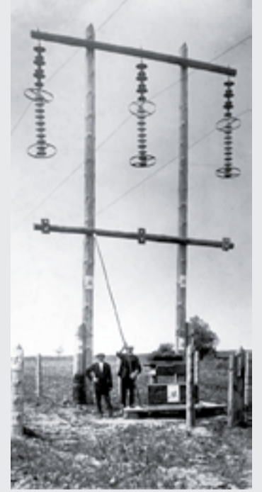
Опоры первой линии электропередачи 35 кВ собирала плотницкая артель
