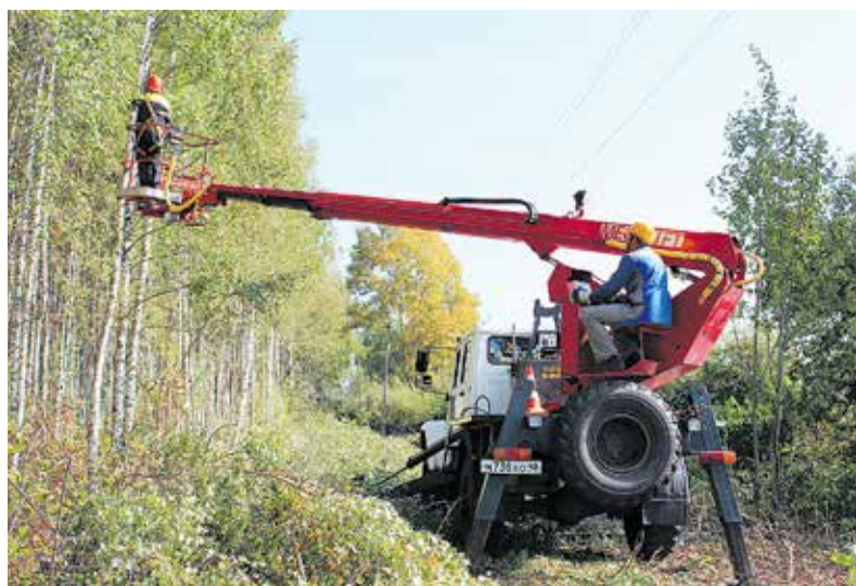
Бригады филиала МРСК Центра — Липецкэнерго занимаются расширением просек вдоль линий электропередачи
