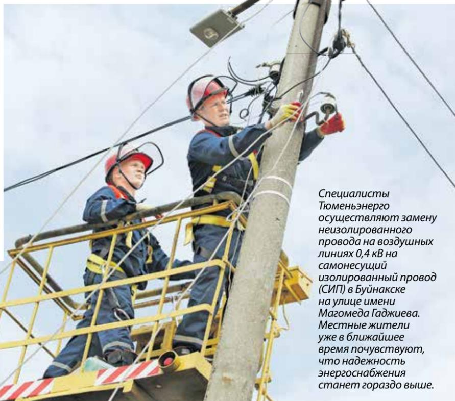
Специалисты Тюменьэнерго осуществляют замену неизолированного провода на воздушных линиях 0,4 кВ на самонесущий изолированный провод (СИП) в Буйнакске на улице имени Магомеда Гаджиева. Местные жители уже в ближайшее время почувствуют, что надежность энергоснабжения станет гораздо выше.
