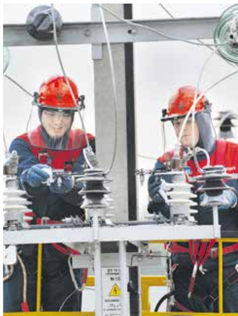
СЕРГЕЙ КОНДРАШОВ, МАСТЕР ЭКСПЛУАТАЦИОННОГО УЧАСТКА ВЛ 0,4–10 КВ КИНГИСЕППСКОГО РЭС ФИЛИАЛА ЛЕНЭНЕРГО — КИНГИСЕППСКИЕ ЭС
