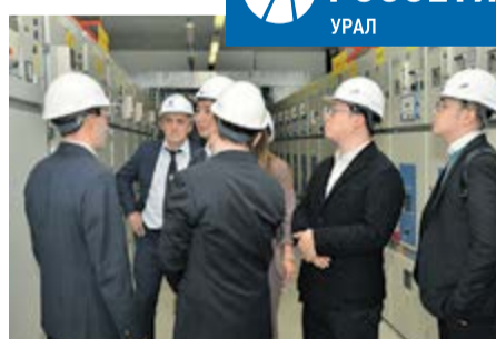
Китайская делегация осматривает подстанцию 110/35/6 кВ «Берег»
