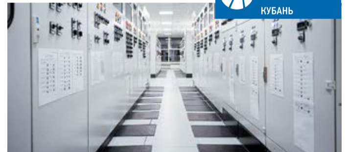
АСУТП подстанции «Порт» передает около 6,5 тысячи телесигналов и измеряемых параметров
