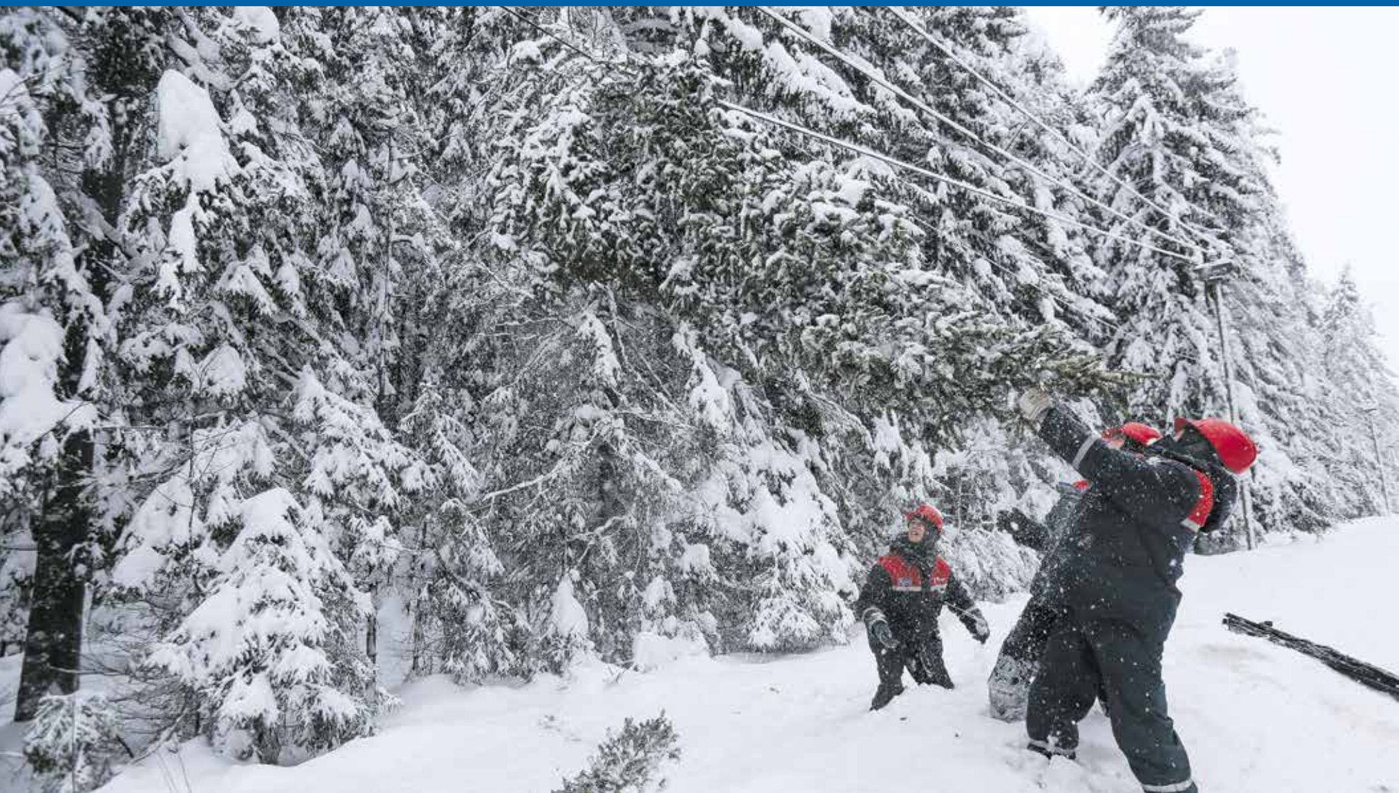
Снегопады и метели в Ленинградской области не дают расслабиться с начала года. Бригада Рошинского РЭС филиала «Выборгские электрические сети» устраняет последствия снежного шторма в поселке Рошино Выборгского района
