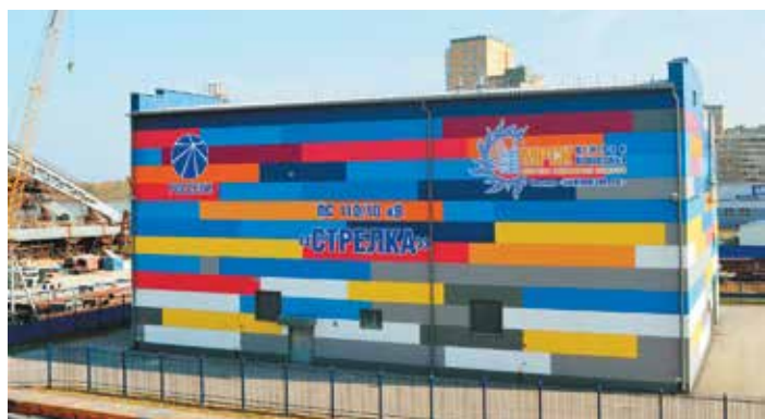
Первым энергообъектом для ЧМ-2018 стала ПС закрытого типа 110/10 кВ «Стрелка», введенная в эксплуатацию в 2014 году. Ее мощностной арены направлены на электроснабжение строящейся футбольной арены, станции метро «Стрелка», а также других инфраструктурных объектов, которые планируется построить в приволжской столице к 2018 году
