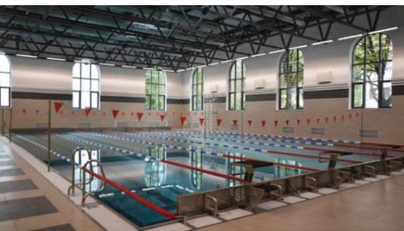
Использованные в проекте инновации — оснащение бассейна энергосберегающей технологией водоподготовки и высокотехнологичной цельнометаллической чашей из нержавеющей стали 25x16 метров; применение запатентованной системы гидравлики, исключая образование зон застоя воды; создание оптимальных санитарно-гигиенических условий — позволили создать объект с высокой энергоэффективностью и значительным экономическим эффектом от внедрения.
